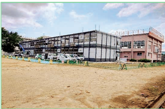
水沢小学校 改装工事 現在仮校舎建築中
