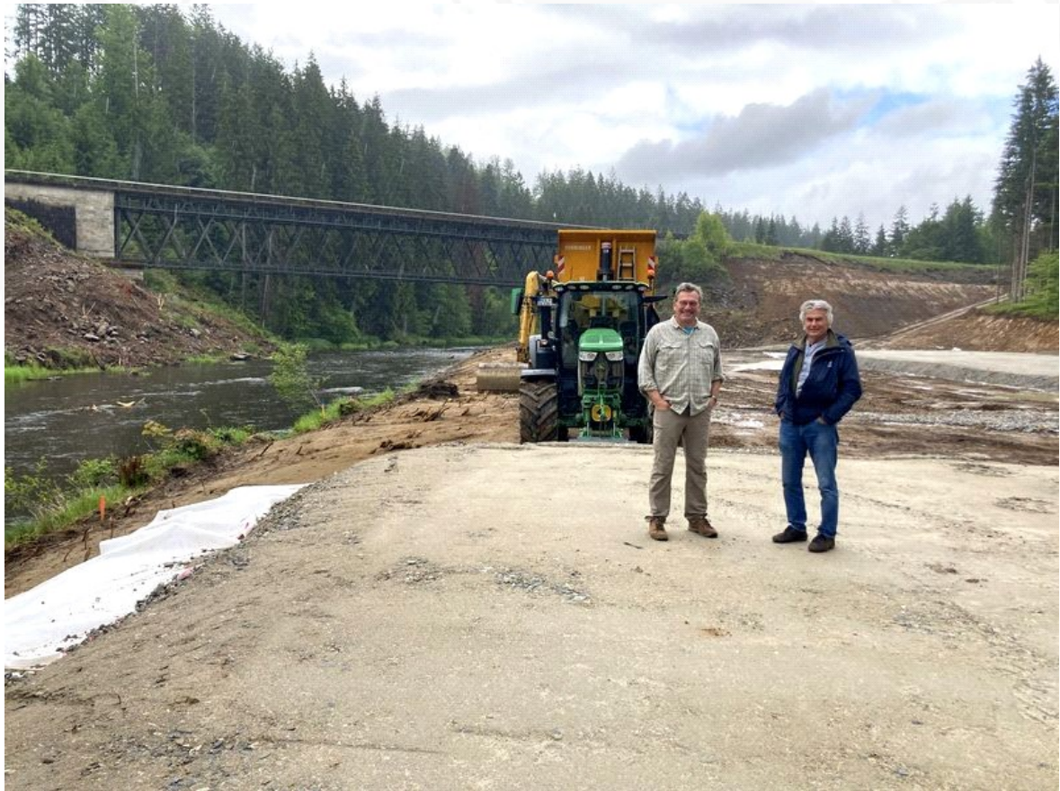
Abbildung 1 - Rainer und Andreas an der Nagerlbrücke mitten im Umbau
