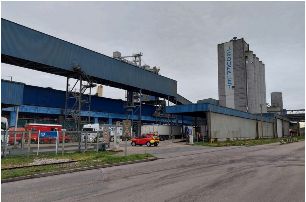
L'incendie pris en charge par les pompiers, lundi 24 février 2025 dans un silo de la Socomac à Canteleu, avait démarré dans la soirée de samedi. (©AF/76actu)
