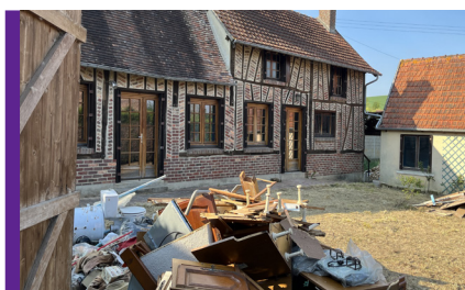
BISTROT DE PAYS : Ouverture du chantier du futur restaurant
