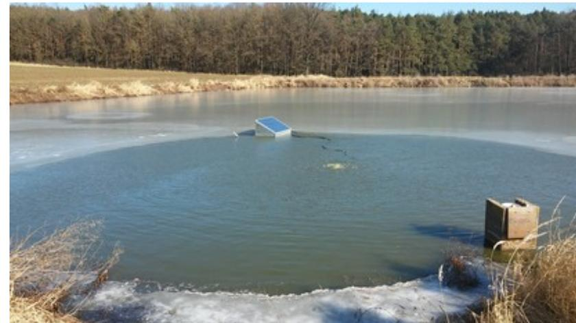
Umwälz-Belüftungs-System mit Solar-Stromversorgung für Fischteiche
