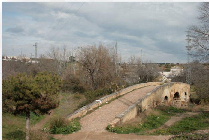
FIG. 5. Puente del Arroyo de Pedroches en Córdoba (© Antonio Monterroso Checa).
