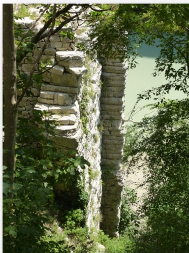
FIG. 4. Aterrazamiento de la Via Flaminia en la zona del Furlo (Las Marcas-Italia) (© Antonio Monterroso Checa).
