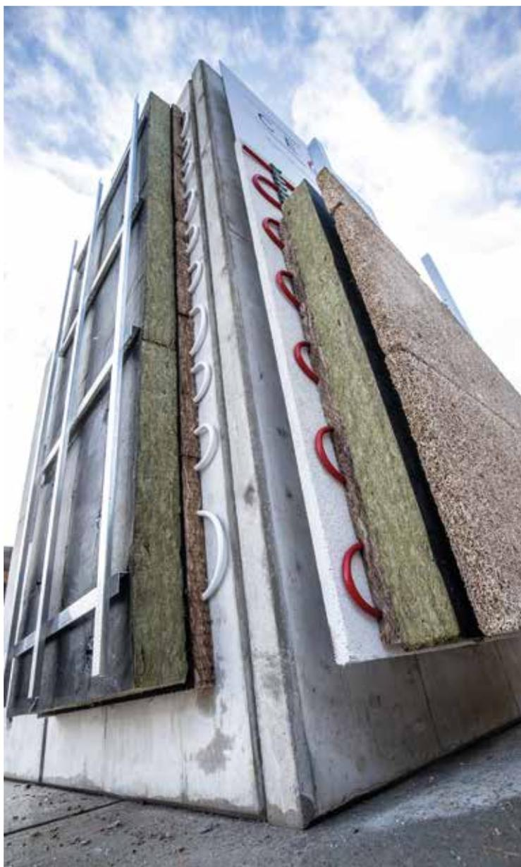
„Die **CEPA®-Fassade** ist intelligentes Energiemanagement. Die gesamte eingetragene Energie wird über die Gebäudehülle verwaltet und verteilt, wodurch der Energieverbrauch drastisch gesenkt wird. Das System **kombiniert Heizen, Kühlen, Dämmen und Speichern** in einem und ist dabei völlig unabhängig von der genutzten Energieform. Ein weiteres großes Plus in puncto Komfort: Die Hausbewohner können während der Sanierung wohnen bleiben.“
