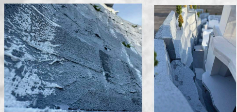
岩壁を見上げた時の様子
