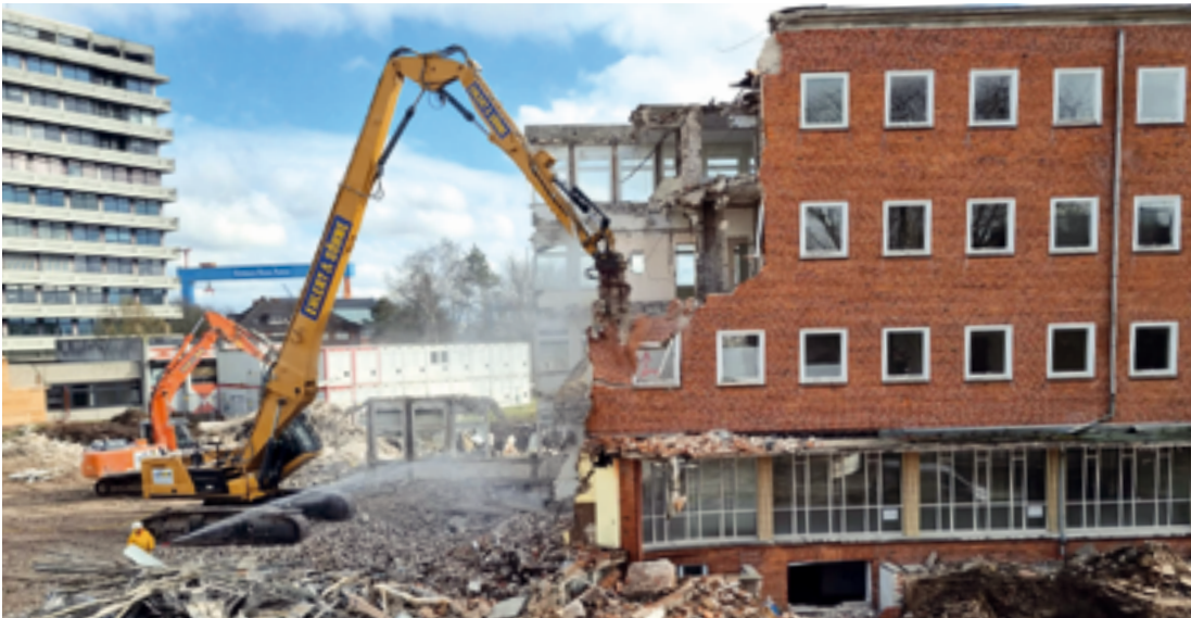
Die alte HNO-Klinik (rechts) wird abgerissen, damit der Verbindungs-(Neu-)Bau zur ZMK (im Hintergrund links) errichtet werden kann.
