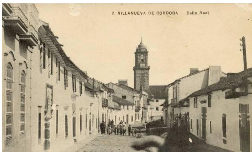
Calle Real de Villanueva de Córdoba
