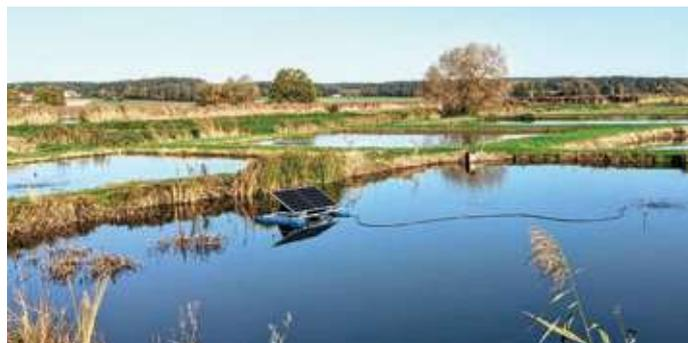
Abb. 5: Schwimmende PV-Druckluftversorgungsinsel bei der Umwälzbelüftung zweier benachbarter Teiche (900 m<sup>2</sup> & 450 m<sup>2</sup>; Tiefe ~ 0,8 m)
