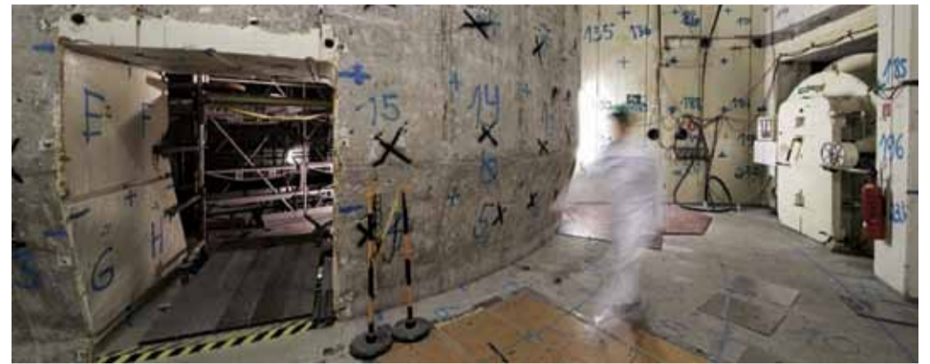
Foto: Zustand 2031, Freimessung aller Bereiche, Quelle: BKB AG
