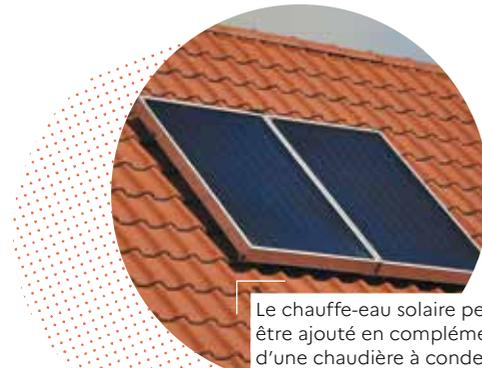
Le chauffe-eau solaire peut être ajouté en complément d'une chaudière à condensation par exemple.
