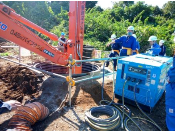
[ライナー立坑築造状況]
