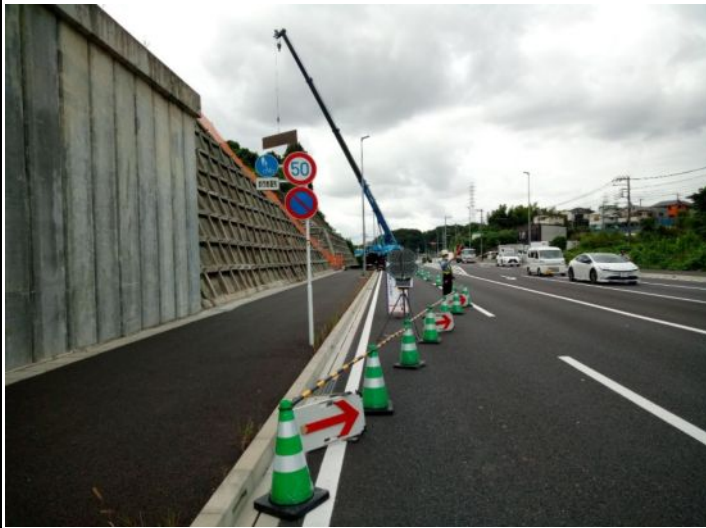
＜資機材 (敷き鉄板) 搬入状況＞
