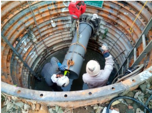
[塩ビ管挿入状況]
