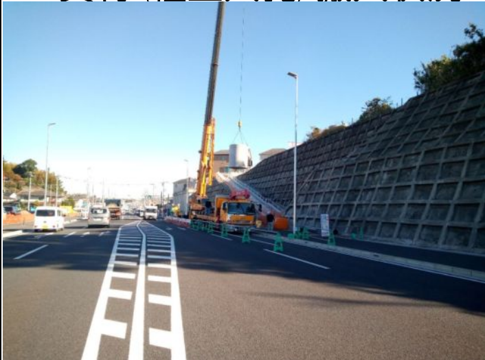
＜資材 (組立人孔) 搬入状況＞
