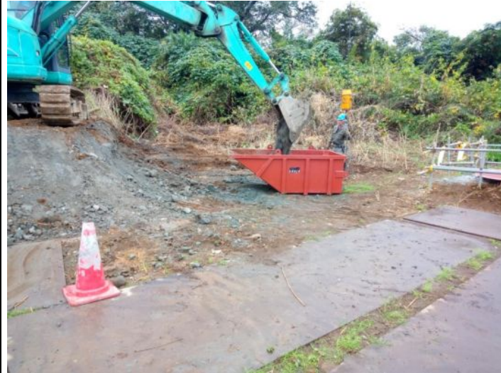
＜建設発生土搬出状況＞
