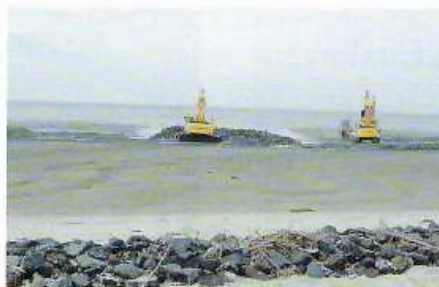
19.05.11 Bühnenbau Altenbruch Schüttsteine f. Bühnenaufbau
