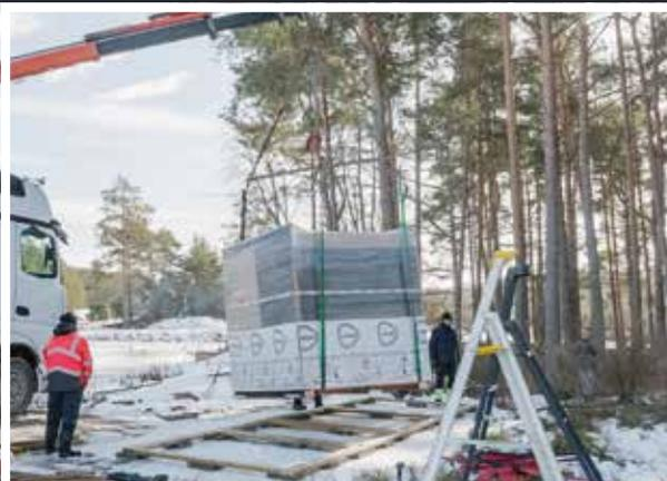
Die Kirami FinVision® Annex -Module werden komplett und nahezu vollständig montiert an ihren Bestimmungsort geliefert.
