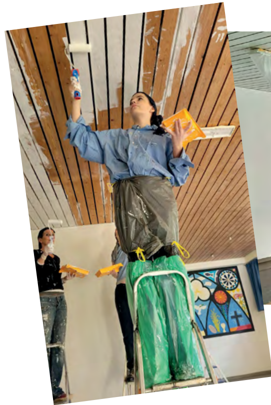
Das engagierte Team beim Streichen des Kellerraums
