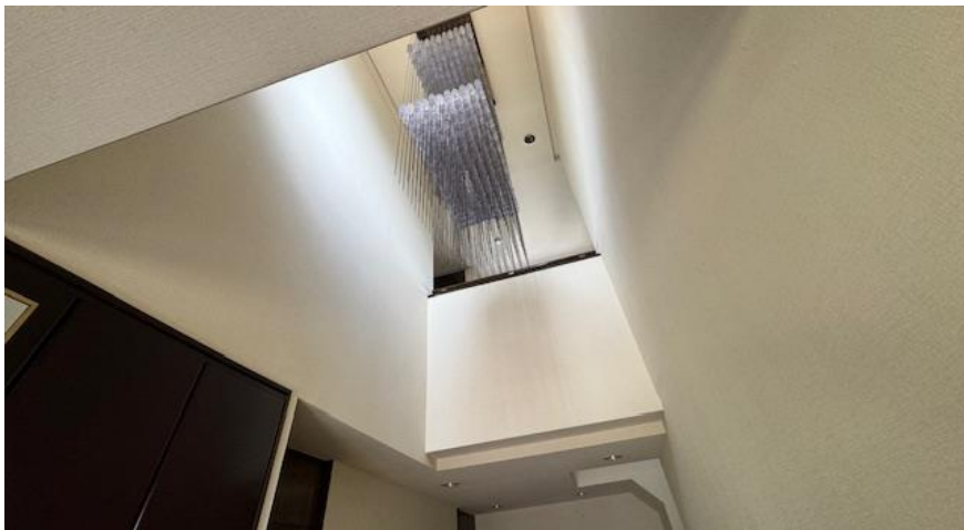
吹き抜け（玄関ホール上部）
