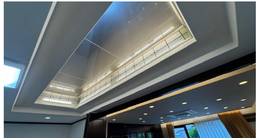
吹き抜け（食堂上部）
