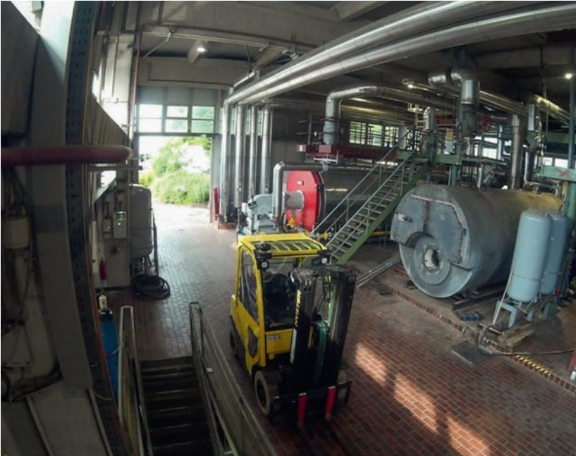
Der alte Heizkessel wurde demontiert und ausgebaut, um Platz für seinen Nachfolger zu machen.
