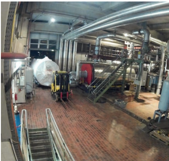
Der neue Kessel 2 wird ins Kesselhaus transportiert.
