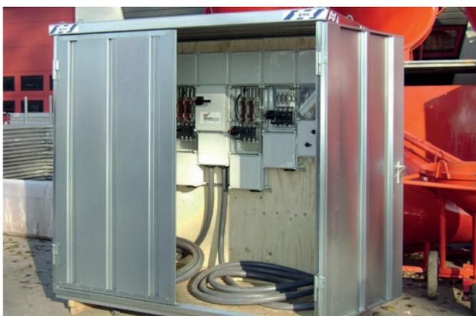
SC3000 als Einhausung für einen Stromverteilerkasten
