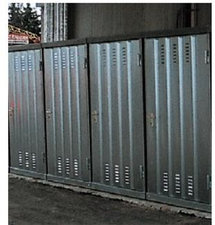
Container mit Kiemen zur Belüftung
