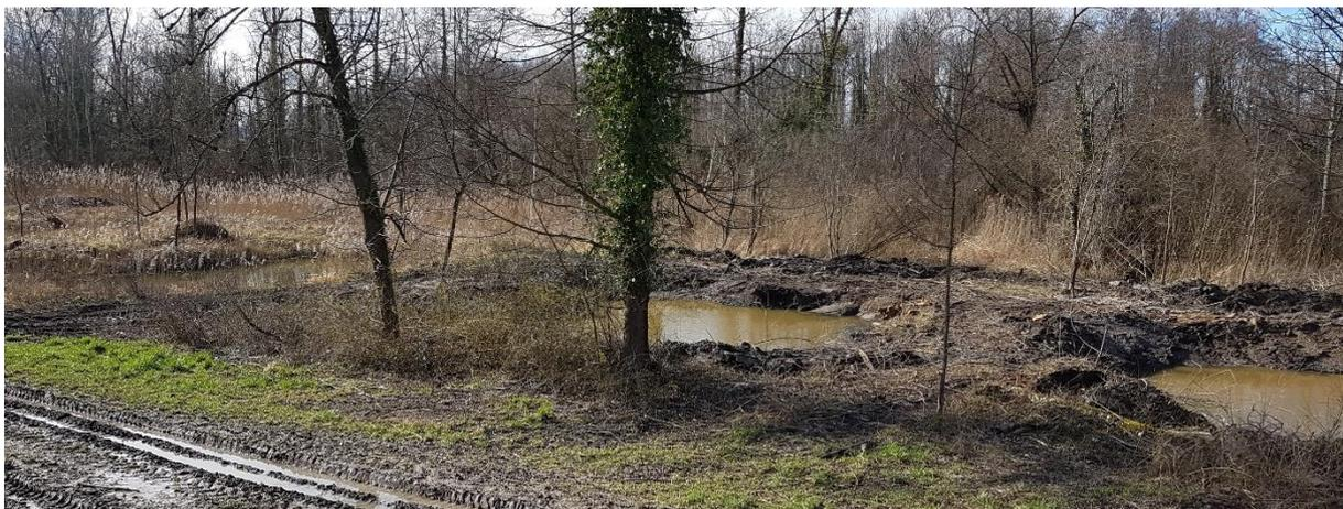
Das ausgebaggerte Material aus organischer Substanz, zersetzten Pflanzenresten und Schlick bleibt vor Ort und wird am Ufer eingebaut oder auf Haufen abgelegt. Das dabei untergemischte Astmaterial schafft Hohlräume und strukturiert den Aushub.
