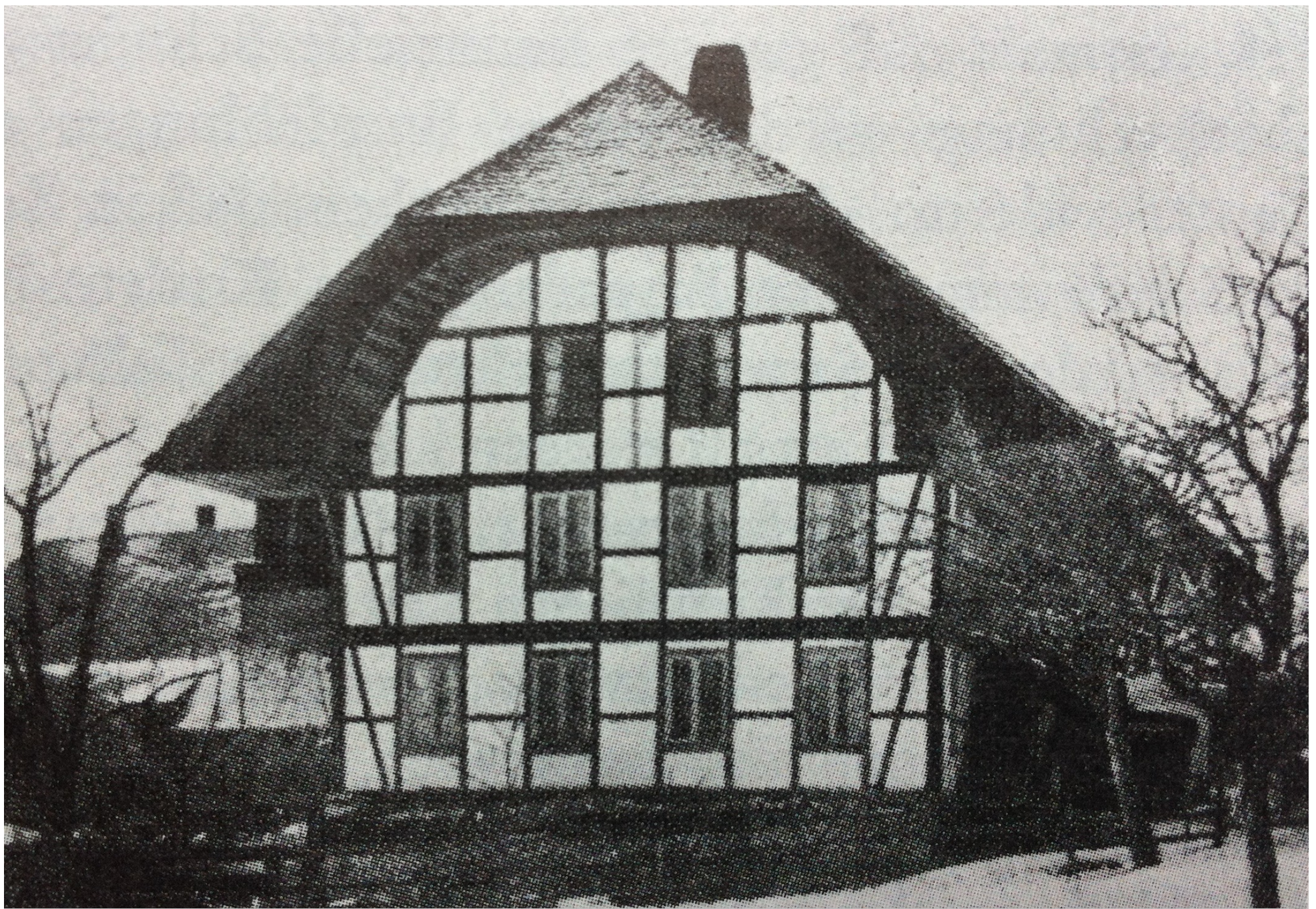
Sekundarschule von 1856-1860 Käsereigebäude von Zäziwil
