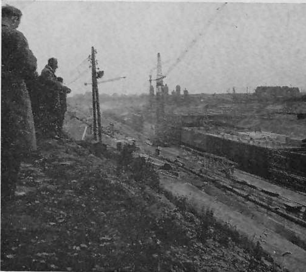
Besichtigung des Tunnelbaues in Rendsburg
