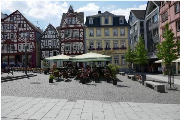
**Abb. 51: Kombination von Naturstein (Basalt) und Betonwerksteinplatten in Hachenburg (Westerwald)**
