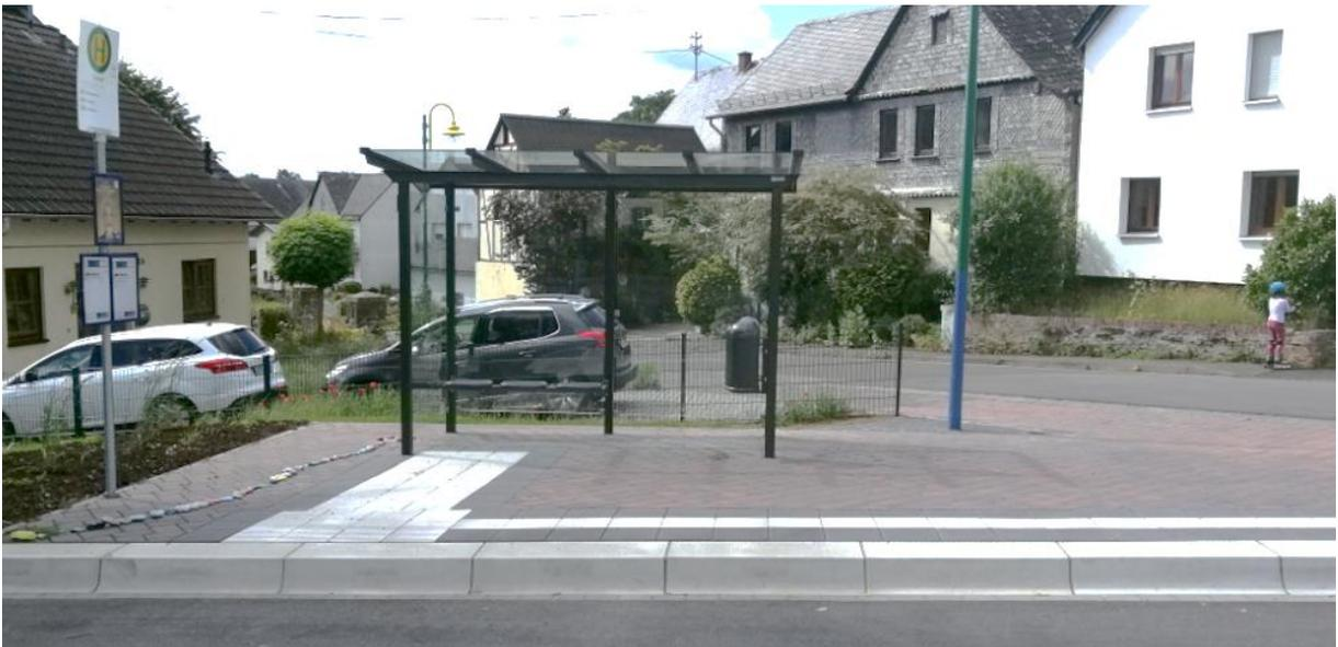
Abb. 54: Ein Beispiel einer barrierefreien Bushaltestelle in Schwall
