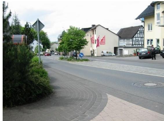
Abb. 50: Kombination von Naturstein (Basalt) und Betonwerksteinplatten in Hachenburg (Westerwald)
