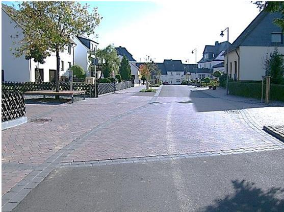
Abb. 39: Geschwindigkeitsreduzierung durch Einbinden der Seitenräume in Boppard-Buchholz
