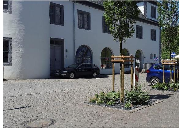
**Abb. 42: Natursteinpflaster (Basalt Großpflaster in ungebundener Bauweise in Boppard)**
