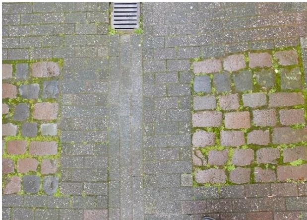
Abb. 20: Beton und Natursteinpflaster (Basalt, Grauwacke)
