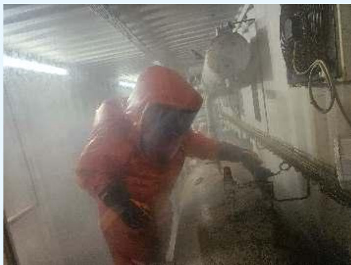
Abb.2: Abdichten einer Ammoniak-Leckage unter Vollschutz Foto: Andreas Leisch
