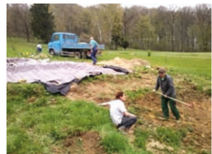
Die Grube für das Biotop wird ausgehoben.
