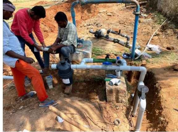
Komplettüberholung des Tiefwasserbrunnens
