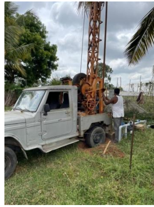
Komplettüberholung des Tiefwasserbrunnens
