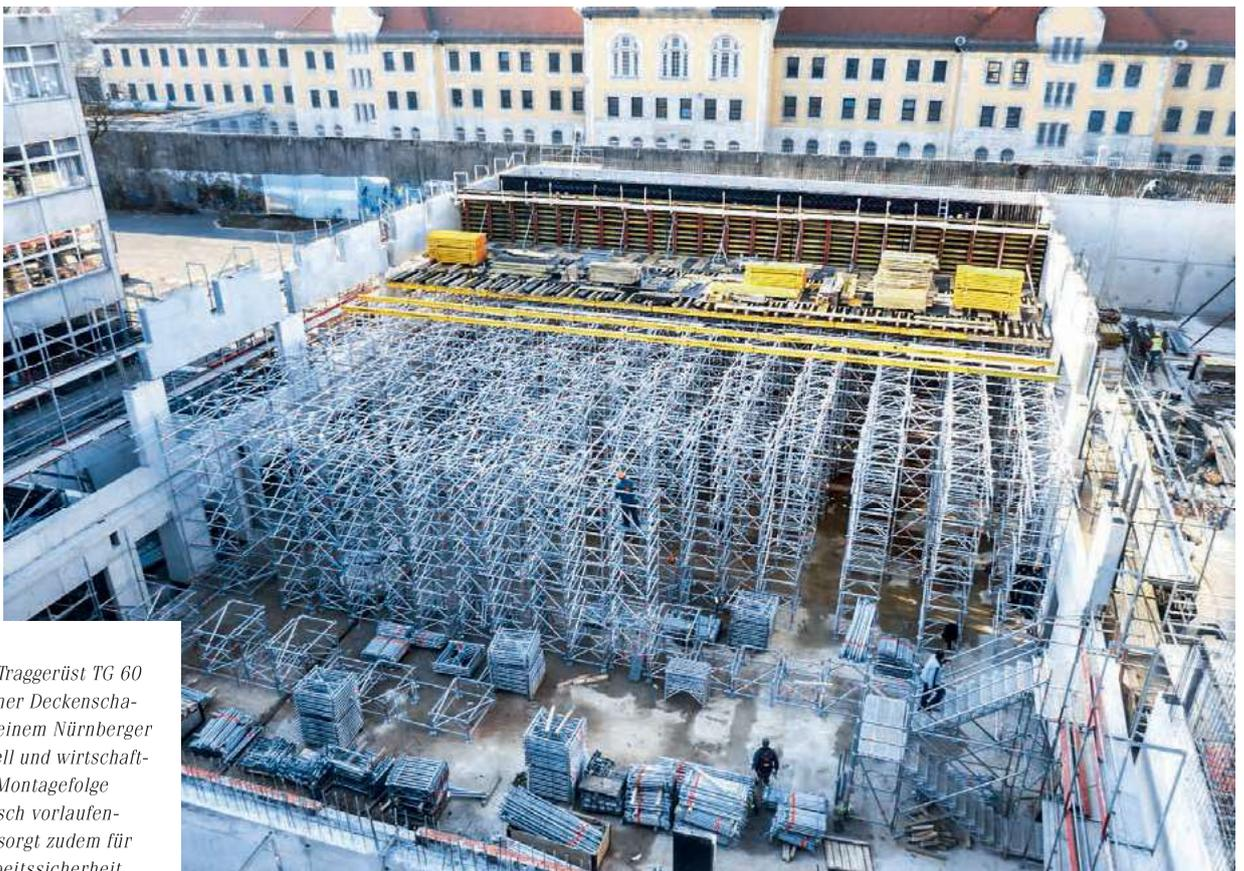
*Mit dem Allround Traggerüst TG 60 ist die Montage einer Deckenschalung, wie hier an einem Nürnberger Gymnasium, schnell und wirtschaftlich möglich. Die Montagefolge mit dem automatisch vorlaufenden Seitenschutz sorgt zudem für größtmögliche Arbeitssicherheit.*
