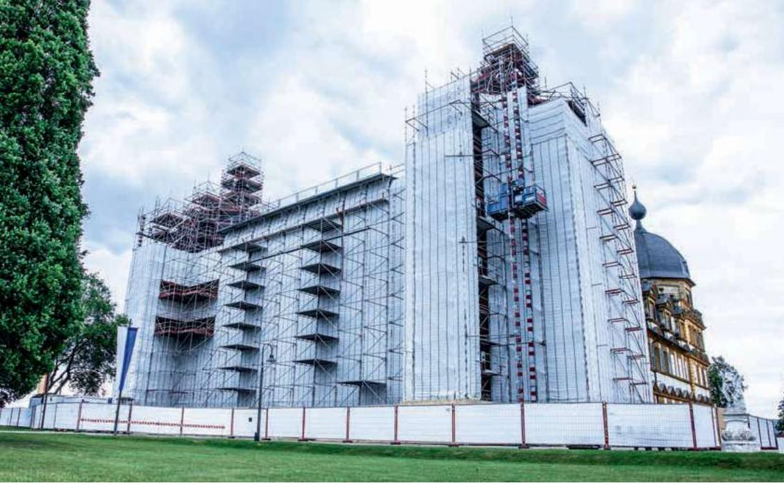
Mit der temporären Gerüstfassade sieht das Gebäude eher nach einem modernen Kunstobjekt von Christo aus, denn nach einem Schloss. Das Fassadengerüst aus Allround Material in Kombination mit dem Kassettendach ermöglicht den Restauratoren ein sicheres und wettergeschütztes Arbeiten auf allen Ebenen und einen einfachen Materialtransport. Die gesamte Gerüstplanung wurde digital in 3D durchgeführt, für eine effiziente Baustellenplanung und Materiallogistik.
