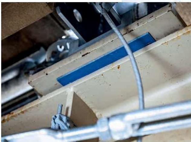
Die schwimmende Lagerung ermöglicht es, die beim Schlagen der Glocken auftretenden Schwingungen von etlichen Zentimetern auszugleichen.
