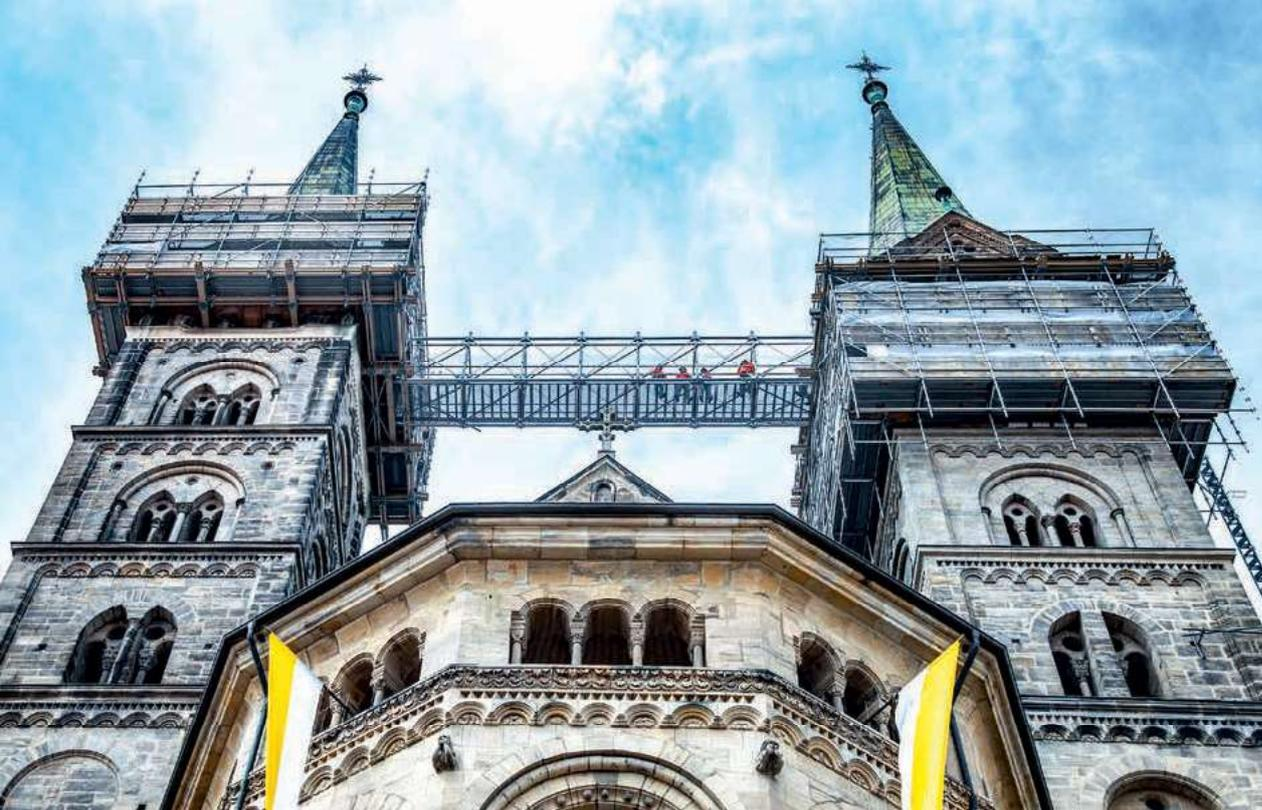
Die Fassade der oberen Teile der beiden vorderen Türme des Doms wird aktuell abgestrahlt und neu saniert, um den Umwelteinflüssen besser standhalten zu können. Die dafür nötigen Gerüste wurden auf Stahlträgern montiert, die durch die Türme geführt sind. So musste nicht die komplette Höhe eingerüstet werden und man konnte erheblich Gerüstmaterial einsparen.
