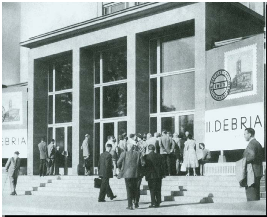
Eingang zur DEBRIA-Halle
