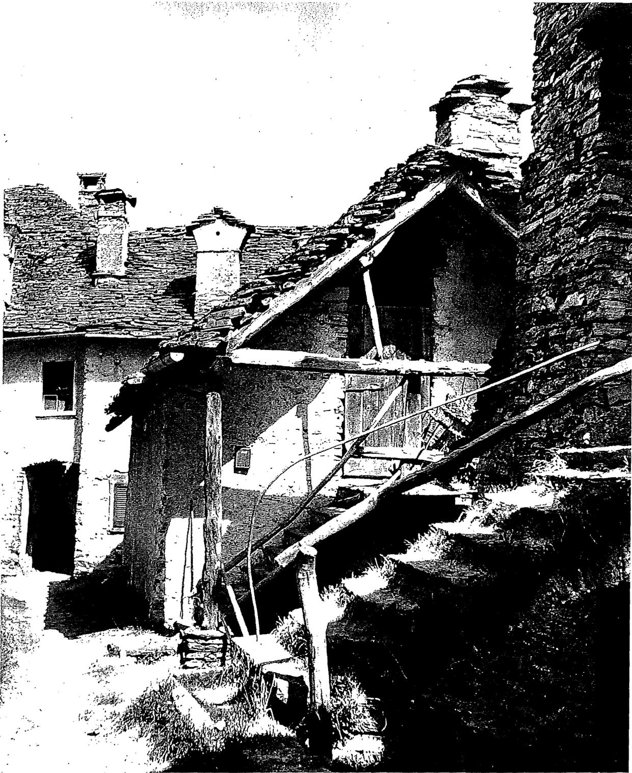
Vordach über einer Treppe, die zum Heuboden führt. Der Ankerbalken ruht auf den vorspringenden Mauerpfeifen und bietet mit diesen zusammen den Sparren Halt. Mit der Zeit wurde zwischen dem Ankerbalken und einem Sparren eine Verstrebung notwendig (Costa bei Intragna, Centovalli).
