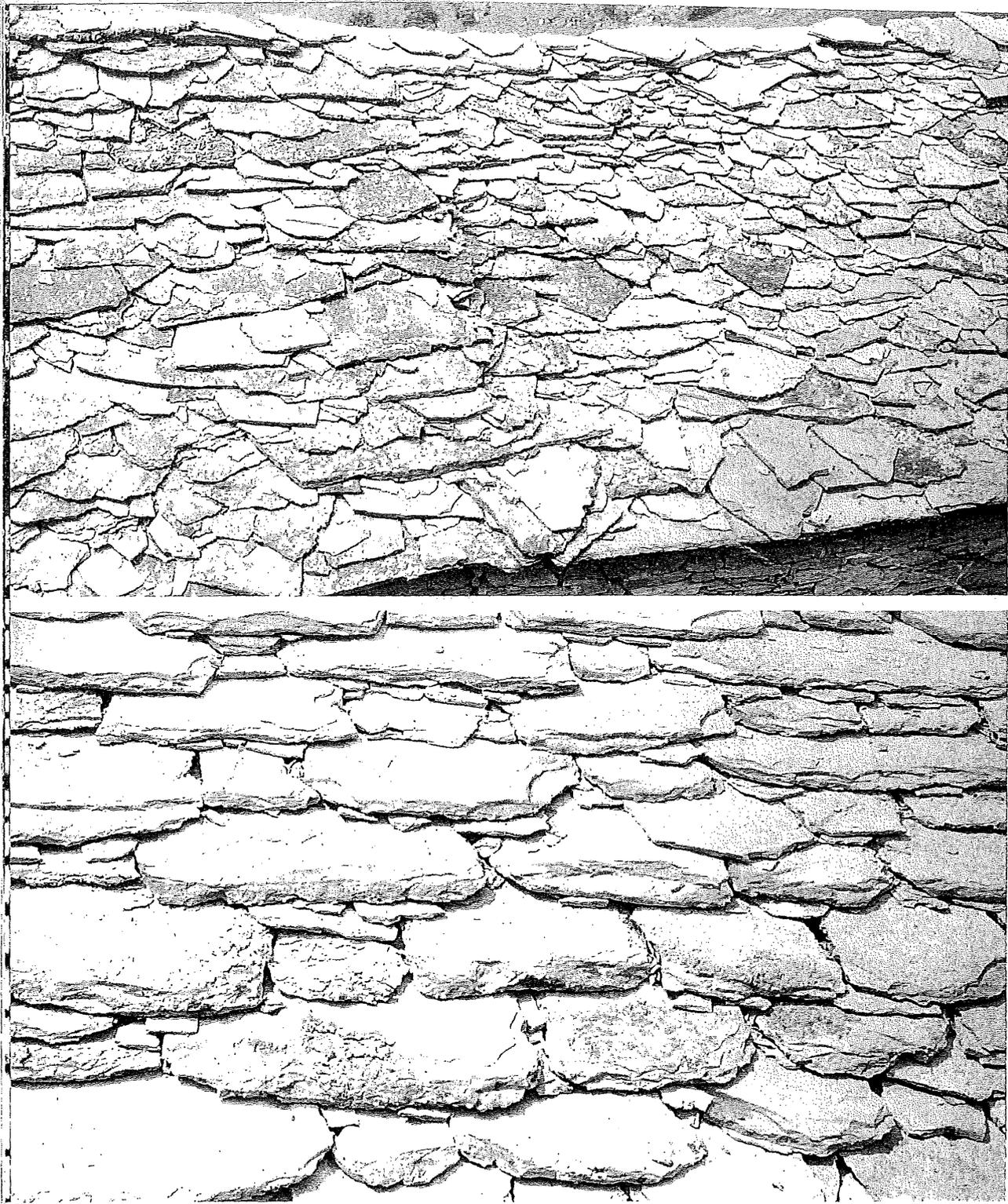
Zwei Beispiele von Dächern auf einer Alp des Generoso: Oben ein sehr altes Dach — Frost und Unwetter haben die Platten langsam zerbröckeln lassen —, unten ein neues Dach, das mit demselben Kalkschiefer gedeckt wurde.
