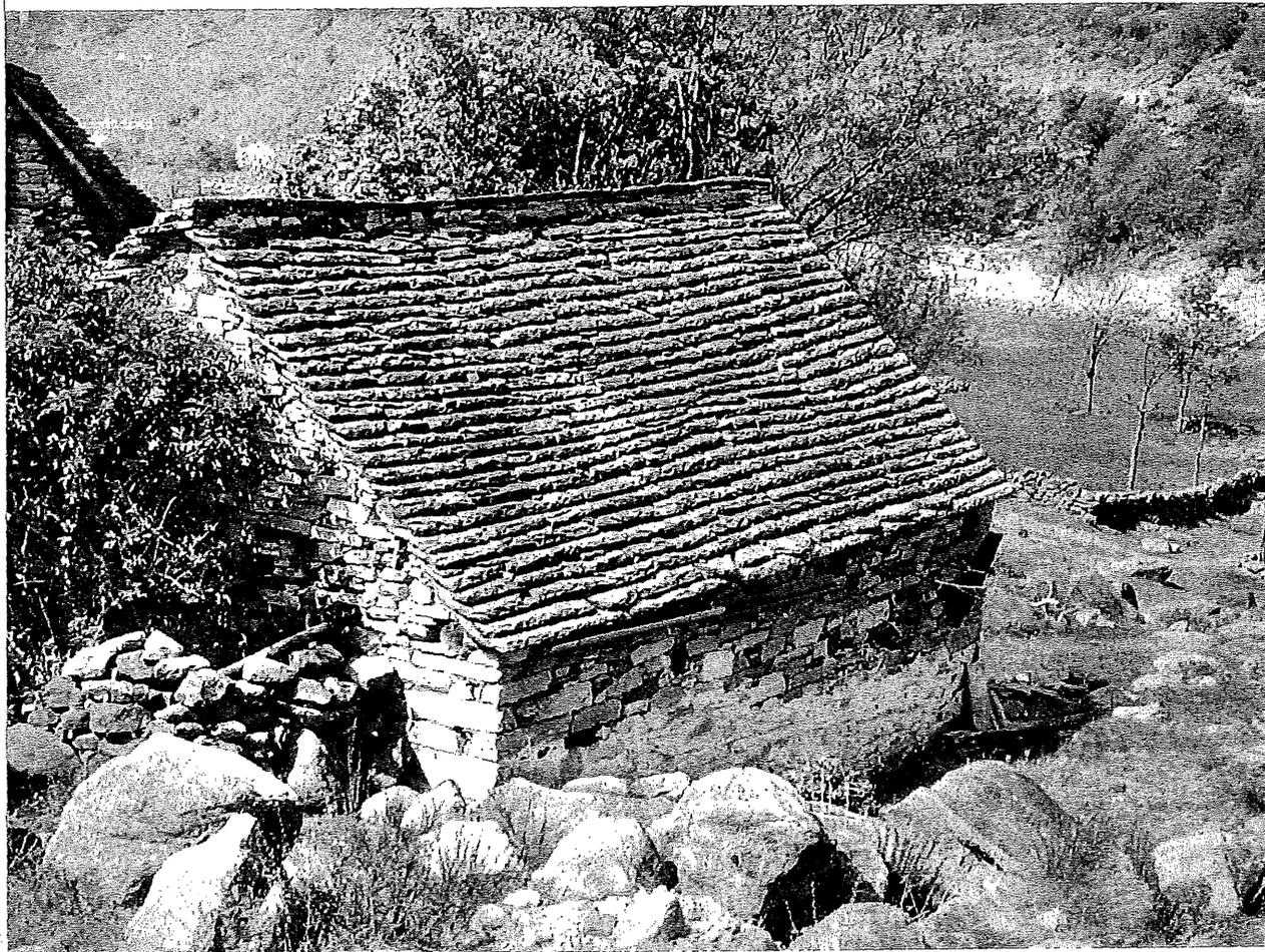
Das am Bauort und in der näheren Umgebung vorhandene Material bestimmte die Beschaffenheit des Daches. Wie Aufnahme zeigt, findet man im Maggiatal Dächer mit gleichmäßig ausgerichteten Plattenreihen, wo die *béola* (schieferarti Granit) in der Nähe zu haben ist.
