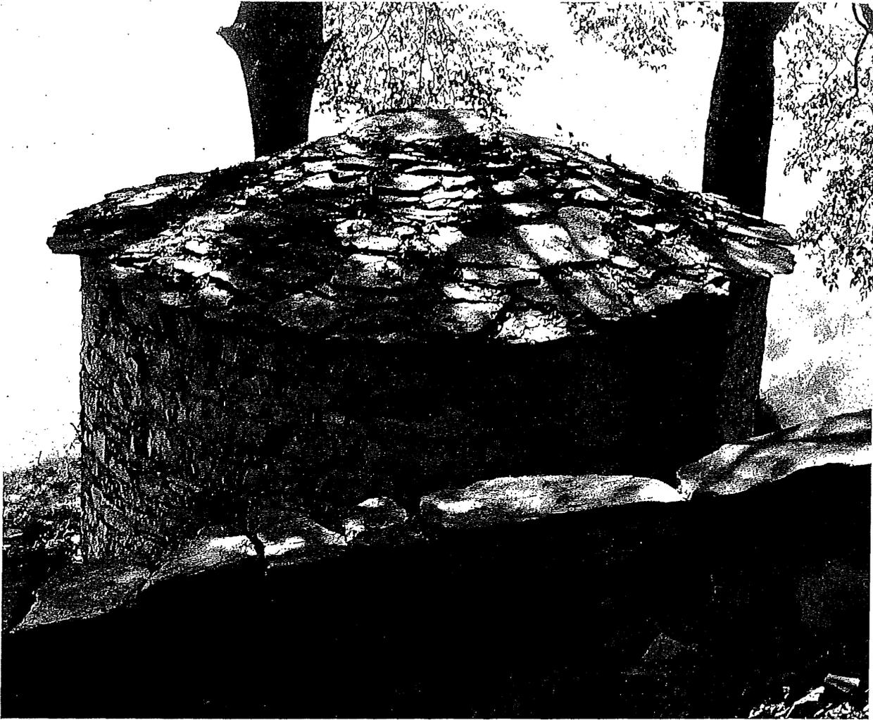
Kegeldach einer *nevèra* auf einer Alp des Generoso. Die *nevèra* ist ein Rundbau, der drei Meter aus dem Boden ragt und vier bis fünf Meter in der Erde eingegraben ist: Durchmesser vier bis fünf Meter. Im Winter wurde die *nevèra* mit Schnee ausgefüllt und diente im Sommer als Kühlhaus für Milchprodukte.
