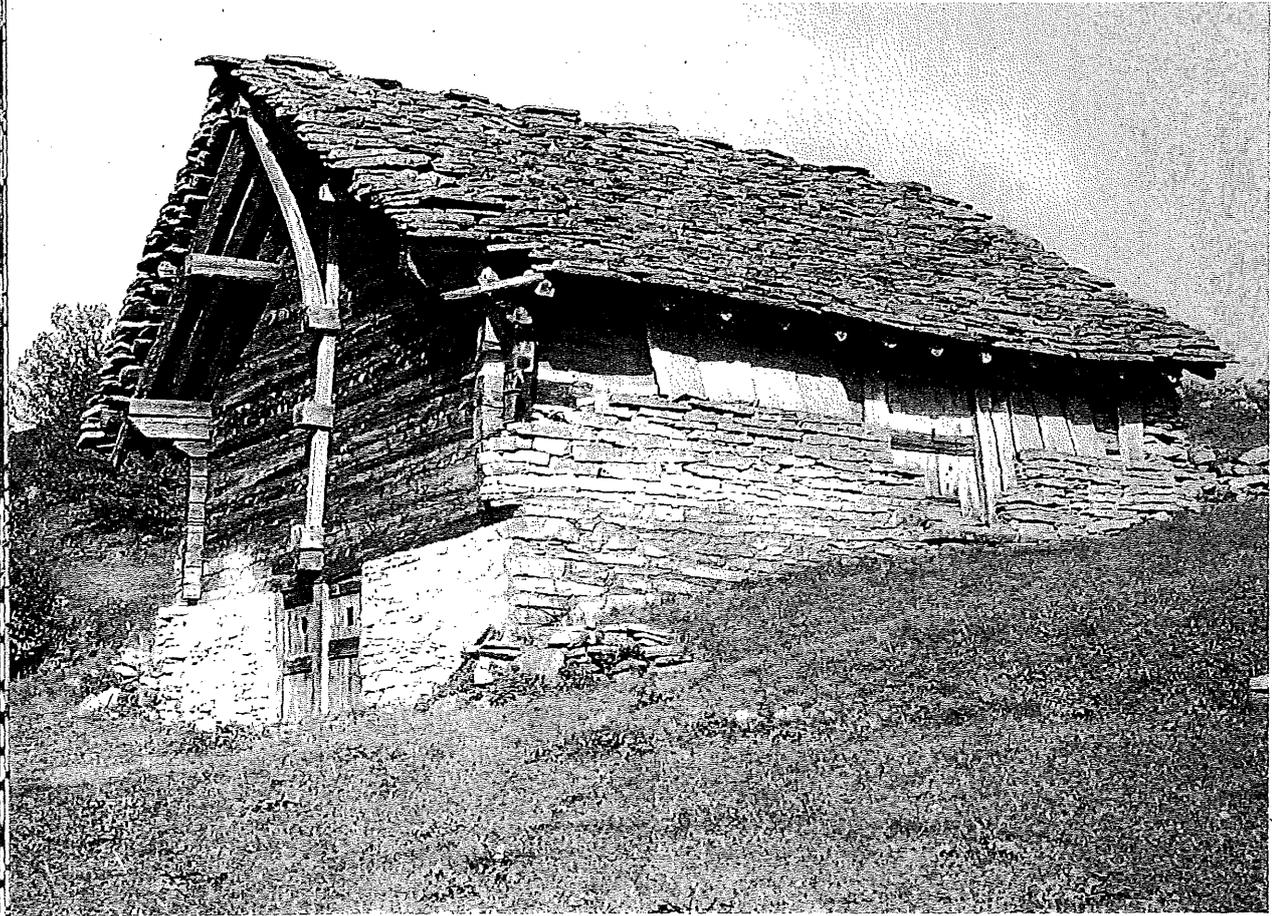
Dach eines Maisensäbes auf der sonnigen Terrasse von Sobrio, Cavagnago und Anzonico. Deutlich sieht man die verlängerte und zugleich verstärkte Mauerpfette, welche die drei Sparren hält, die mit Dachpfetten und Firstpfette die Verlängerung des Daches bildet. Ein leicht gekrümmter Balken stützt die Firstpfette.
