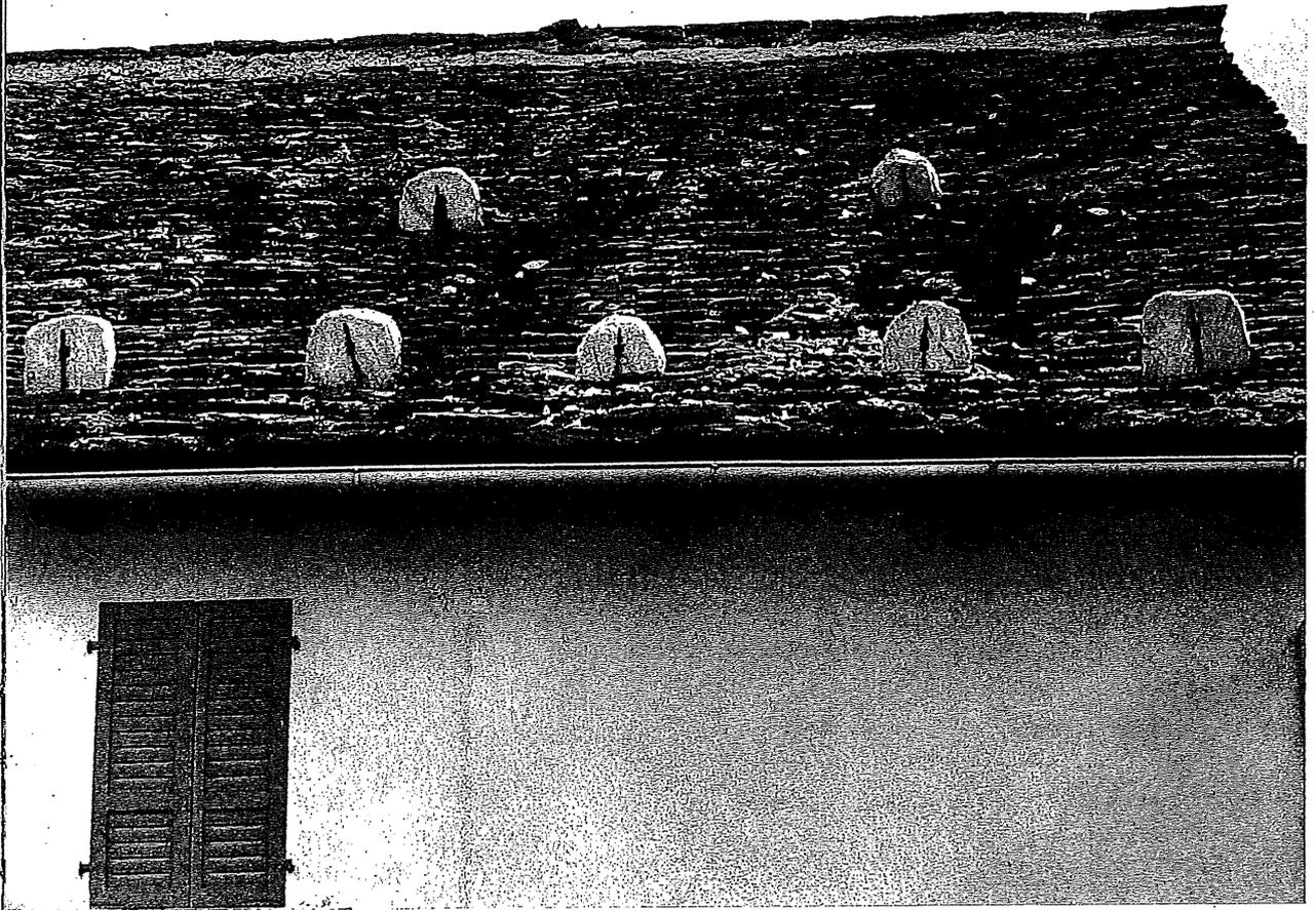
Eine moderne Art, das Abgleiten des Schnees zu verhindern, wie man sie in Bosco Gurin und in Cimalmotto beobachten kann. Die senkrechte Steinplatte wird mit einer eisernen Stange an einer Latte befestigt (Zeichnung Seite 17).
