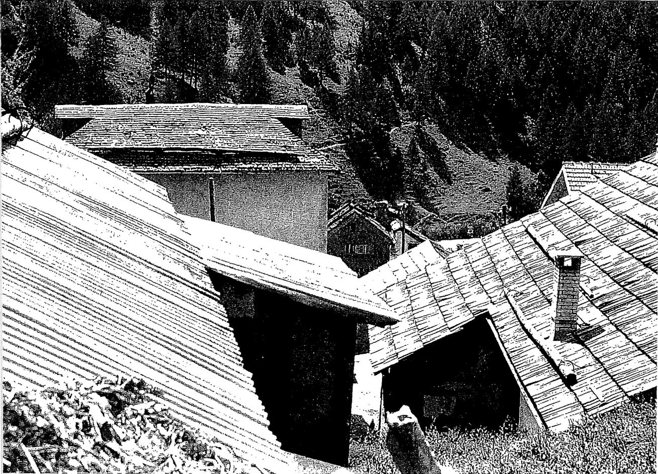
Villa Bedretto: Links ein Blechdach, rechts ein Dach mit Lärchenschindeln. Auf beiden Dächern sehen wir die Stangen, die, mit Eisenringen gesichert, ein Abgleiten des Schnees verhindern sollen. Ein verhältnismäßig neues System: Das älteste wird mit der Zeichnung Seite 19 illustriert. Das Haus im Hintergrund ist mit sehr kleinen Schindeln *stelletta* gedeckt, die dicht auf die Latten genagelt wurden.
