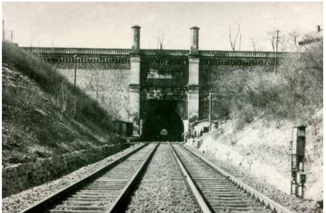
Abb. 1: Das Südostportal des Tunnels Oberau. Der Tunnelbau hatte ca. 300.000 Thaler gekostet (heute ca. 13.380.000 € (Kaufkraftäquivalente laut Deutsche Bundesbank)). Ursprünglich sollte der Tunnel übrigens 812m lang werden. Durch das Anlegen von Einschnitten im Gelände vor den Portalseiten konnte die Länge aber auf 513,3m gekürzt werden.
