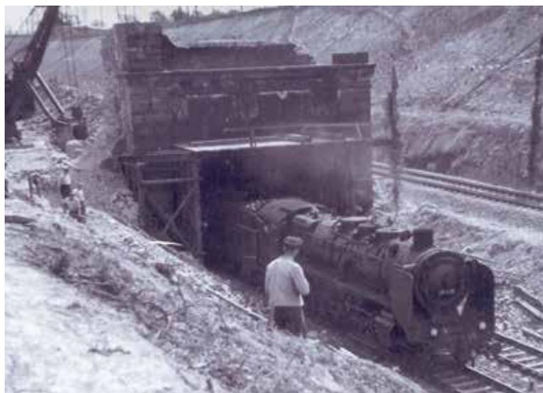
Abb. 3: 1934, der Abbruch des Oberauer Tunnels ist fast abgeschlossen. Die Kosten dafür betragen ca. 1.500.000 Reichsmark (heute ca. 7.350.000 € (Kaufkraftäquivalente laut Deutsche Bundesbank)). Übrigens: Bei Kilometer 92,3 wurde aus dem Material der ehem. Portalbekrönung ein ca. 9m hohes Denkmal aufgebaut (ein Stück vor dem Tierheim Gröbern). Quelle: Heimatstube Niederau
