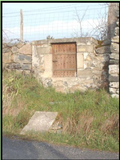
Il s'agit d'un puits en pierres apparentes jointées couvert par une dalle en béton. Une porte en bois ferme l'accès à l'eau.
