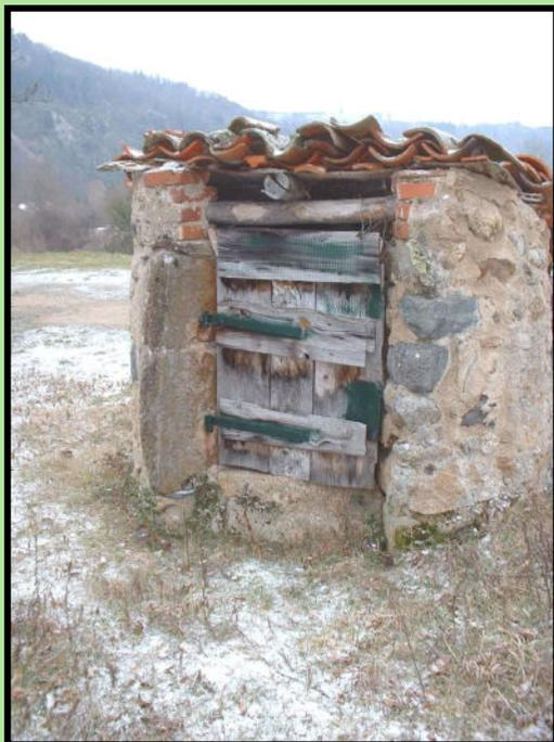
Il s'agit d'un puits en pierres jointées couvert d'un enduit mais qui a pratiquement disparu.
