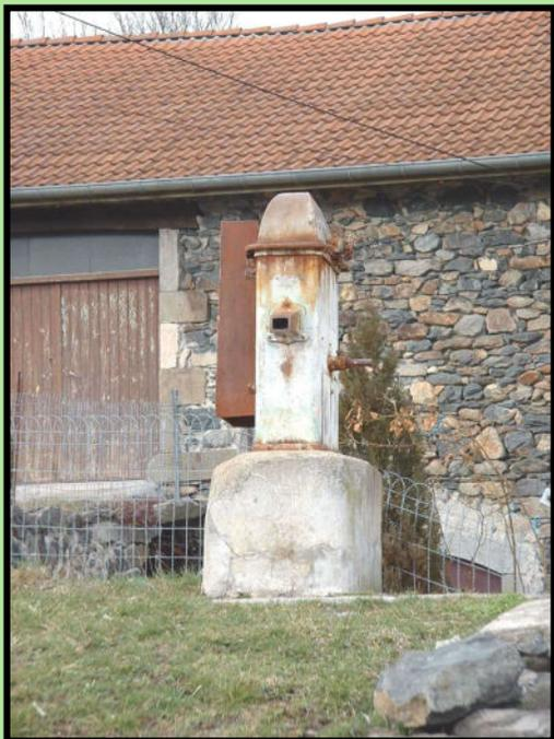
Il s'agit d'un puits avec un socle en béton fissuré et réparé avec du ciment. Le robinet est en fer complètement rouillé. La pompe est cassée et rouillée et donc ne fonctionne plus. Il serait nécessaire de le restaurer car il constitue un élément du patrimoine local original. Il serait nécessaire de nettoyer la pompe pour qu'elle ait un aspect plus esthétique.
