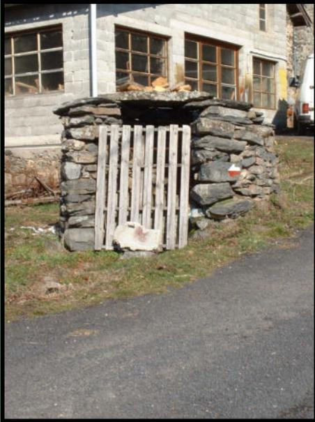
Il s'agit d'un puits en pierres apparentes jointées recouvert d'une dalle phonolite. Ce puits est fermé par une palette de bois tenu par une pierre qui n'est pas très esthétique.
