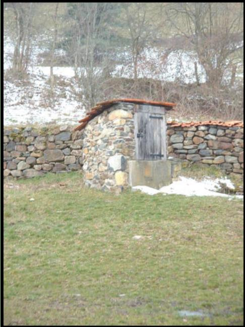
**Il s'agit d'un puits en pierres jointées recouvert de tuiles plates.**
