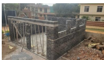
Neubau der Garage
