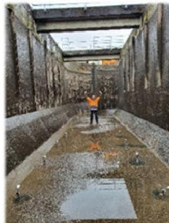
fast 30ig Jahren war, ist eine geringe Menge an Sand und Räumgut angefallen. Ungefähr 6 m<sup>3</sup> Räumgut, das entsorgt werden musste. Ein Gutachter bestätigt, dass der Beton des Beckens sich noch in einem relativen guten Zustand befindet und sollte in 10 Jahren saniert werden, um die Statik des Beckens nicht zu gefährden.
