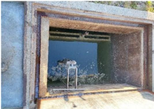
Abgesetzter Schlamm im Retentionsraum
