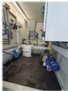
**Kurze Besichtigung Testbetrieb** und Inbetriebnahme CHEPHYKA beim RHV Mondsee auf der Kläranlage in Mondsee. Erklärung CHEPHYKA: CHE steht für chemische Aufbereitung, PHY für physikalische Absetzung, KA für Kläranlage. Die Anlage besteht aus zwei mobilen Einheiten, einer mechanischen Reinigung (Pumpe, Messeinrichtungen und Rechenanlage) einer Dosierstation mit Leitsystem sowie externe Schläuche und Bögen in F" Dimension.
