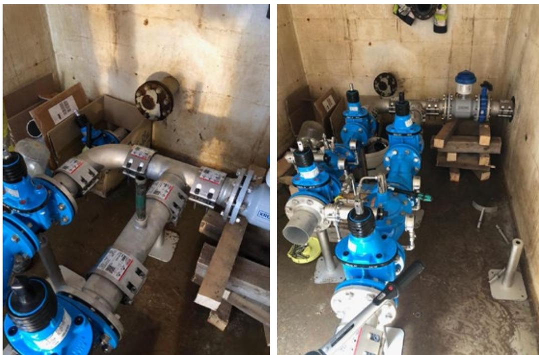
Verrohrung Pumpenschacht DN100 mit Edelstahl-Formteilen und Straub-Grip-Rohrkupplungen
