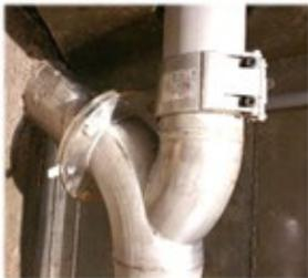
**Nächste** Aufgabe war der Umbau und die Erweiterung der Zulaufleitung von der Pumpleitung des Rechenhaus zum Belebungsbecken. Weiters wurde ein Anschluss für die CHEPHYKA Leitung hergestellt. Mit einer Steckscheibe konnte der Zulauf zum Becken geschlossen werden. Für die Einleitung in den Überlaufschacht wurde auch ein Anschlussstutzen gesetzt. Zusätzlich benötigten wir vier Anschlussstutzen im Ablaufschacht des Nachklärbeckens
