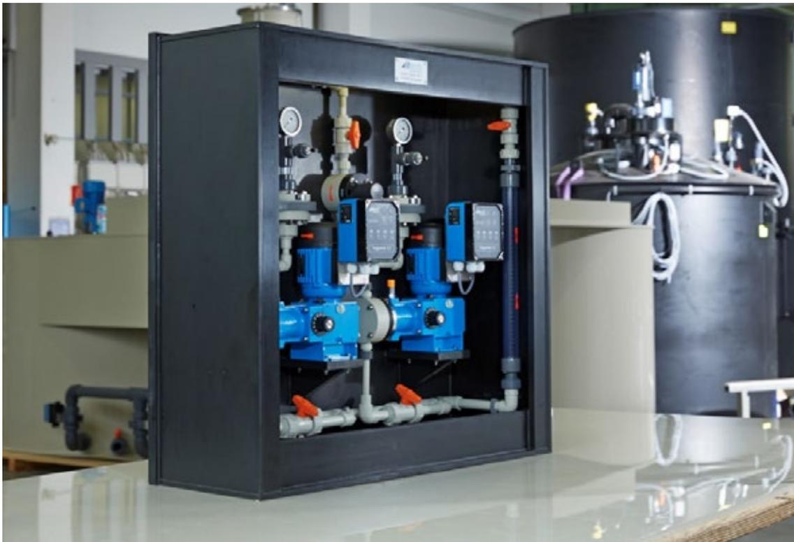
*Bild: Beispiel für ein Eisen-III-Chlorid Dosiersystem*
