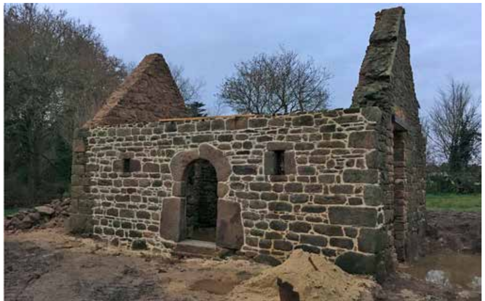
Un gros travail de maçonnerie a permis de repartir sur des bases saines en récupérant un maximum de pierre.
