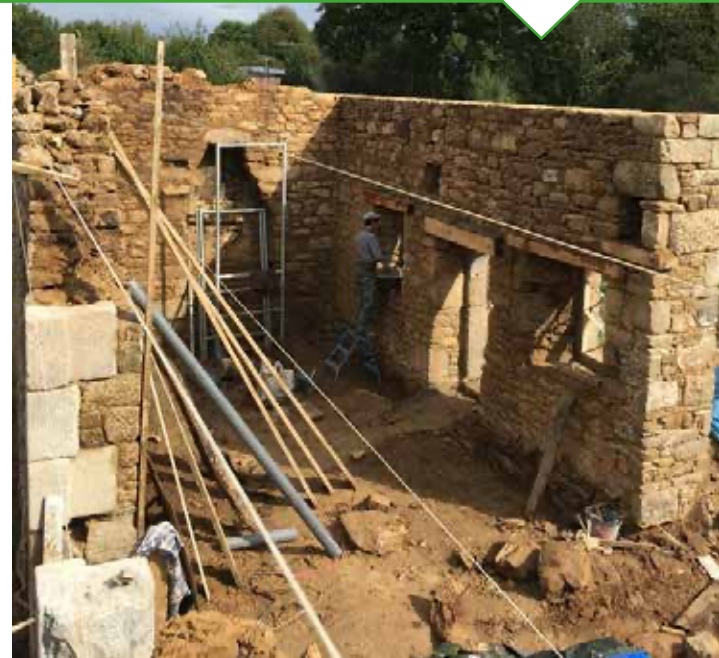
Un gros travail de maçonnerie a permis de repartir sur des bases saines en récupérant un maximum de pierre.
