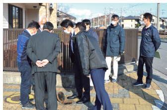
県と新居浜市が連携したデジタル技術での水道管の点検作業
