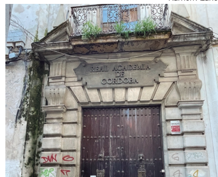
Aspecto actual de la fachada de la Real Academia de Córdoba.
