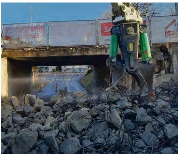
Grosses Bruchmaterial, optimal für den Recycling-Kreislauf
