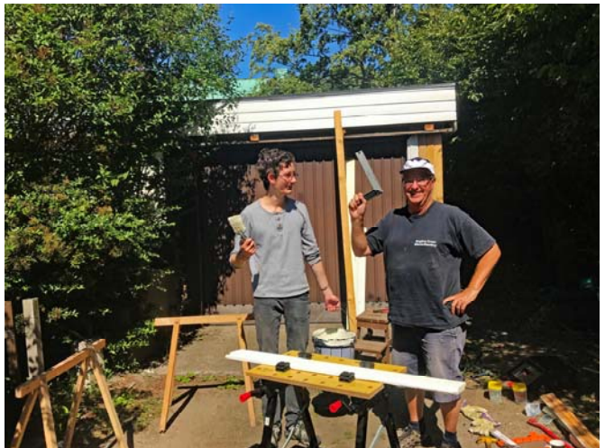
Arne und Henrik renovieren die Garage
