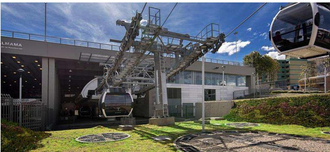
Abbildung 39: Ebenerdige Anordnung der Station<sup>[28]</sup>
