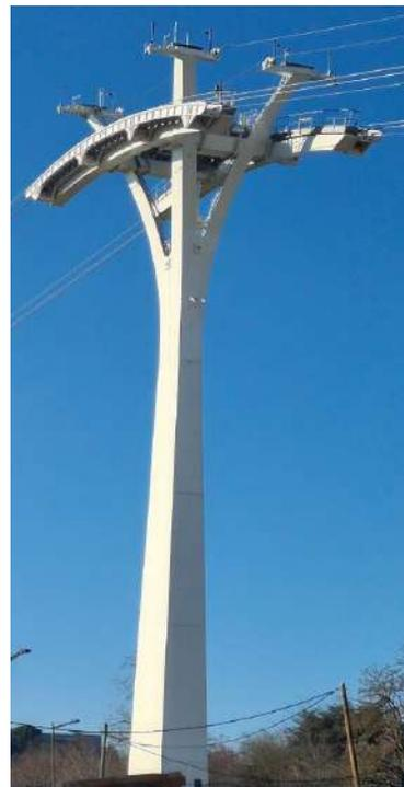
Abbildung 41: Vollwandstütze,
