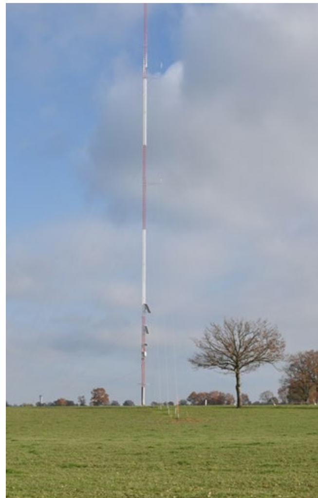
Exemple d'un mât de mesure anémométrique (100 mètres de hauteur) équipé de micros d'enregistrement de l'activité des chiroptères
