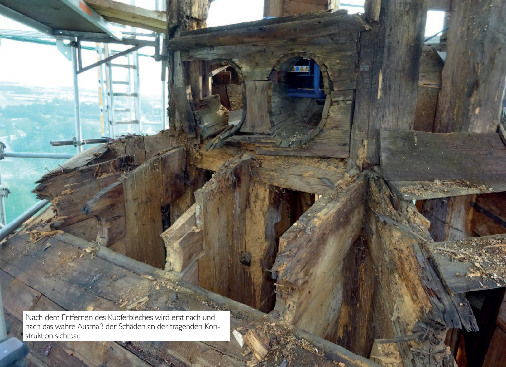
Nach dem Entfernen des Kupferbleches wird erst nach und nach das wahre Ausmaß der Schäden an der tragenden Konstruktion sichtbar.
