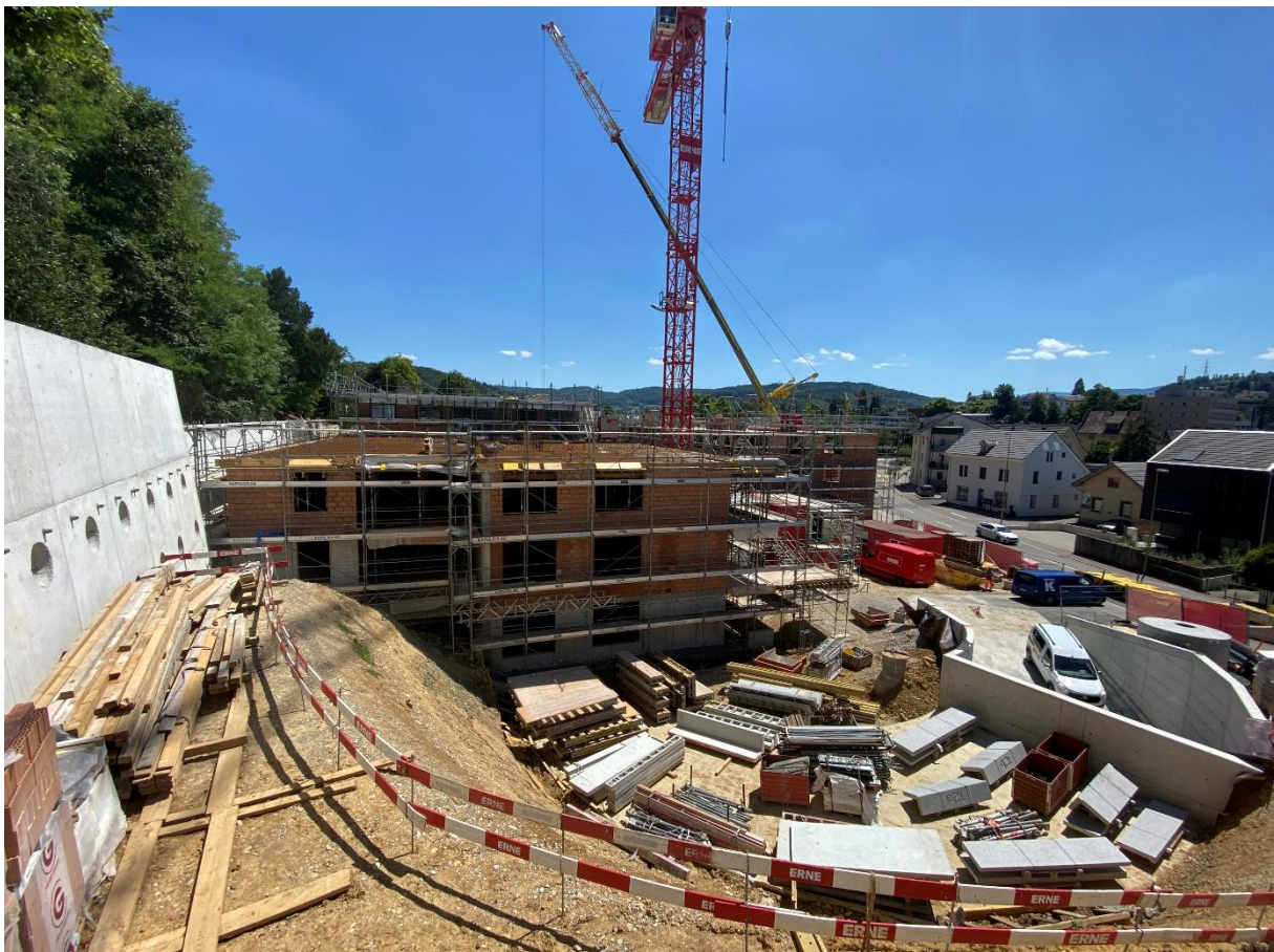
18.07.2025: Die Decke zum 3. Stockwerk wird verschalt, das letzte Stockwerk
