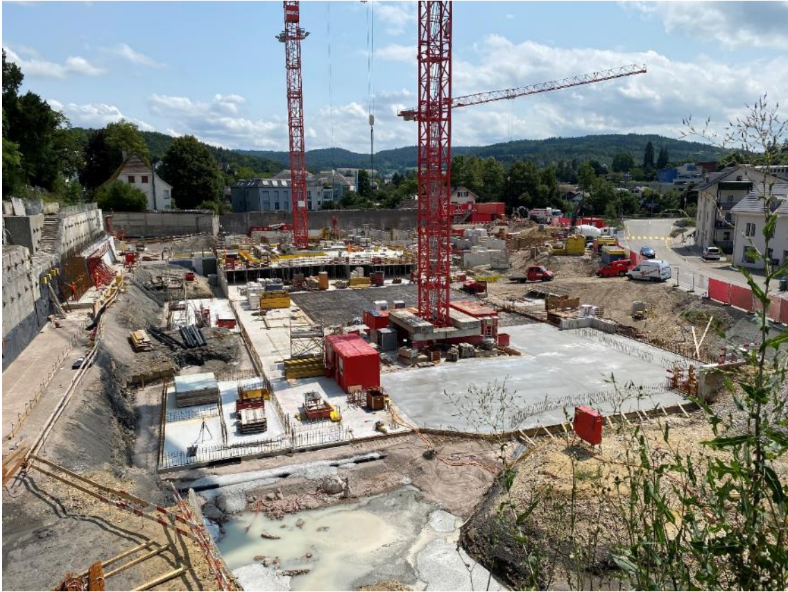
24. Juli 2024: Gesamtansicht: eisen legen .... betonieren ... Eisen legen ...
