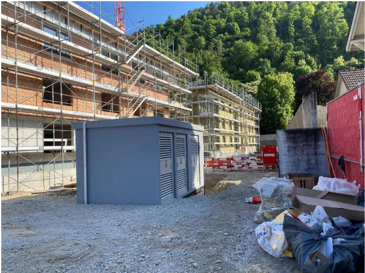
18. Mai 2025: Fenster werden eingesetzt, beim ersten Gebäude die Isolation
