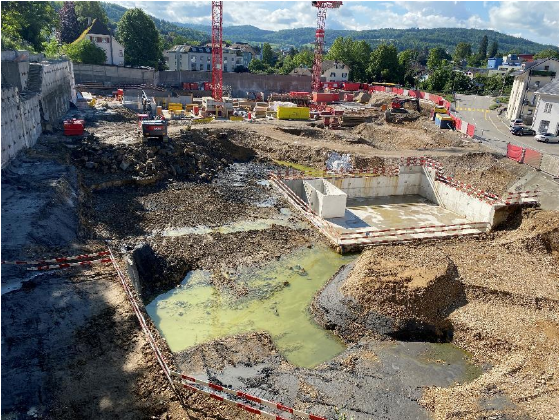
24. Mai 2024: Gesamtansicht der Überbauung
