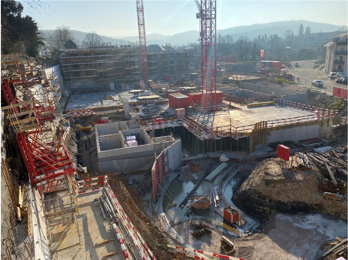
27. Dezember 2024: Im Vordergrund entsteht die Einfahrt zur Tiefgarage
