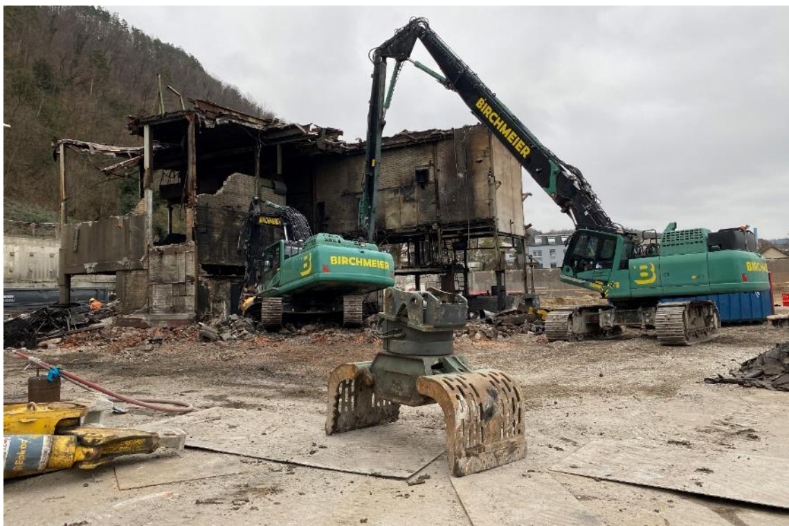
4. März: Bagger links magnetet die Stahlteile, Bagger rechts reisst sie frei.
