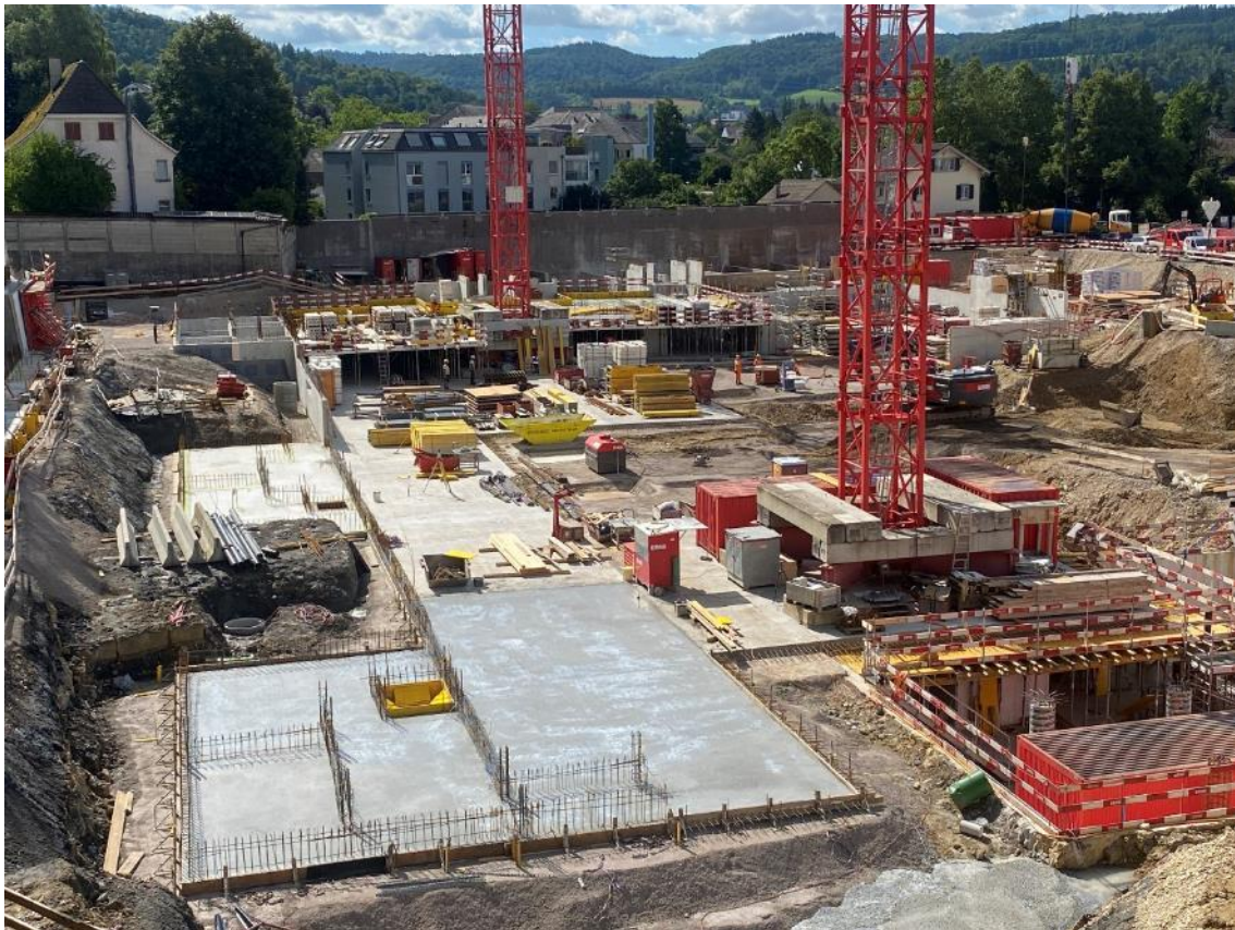
3. Juli 2024: Es stehen 3 Krane. Es wird laufend betoniert. Es geht schnell vorwärts.
