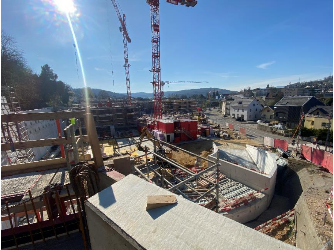
2. April 2025: Die Stützmauer ist fast fertig, die Einfahrt zum Parkhaus betonierte
