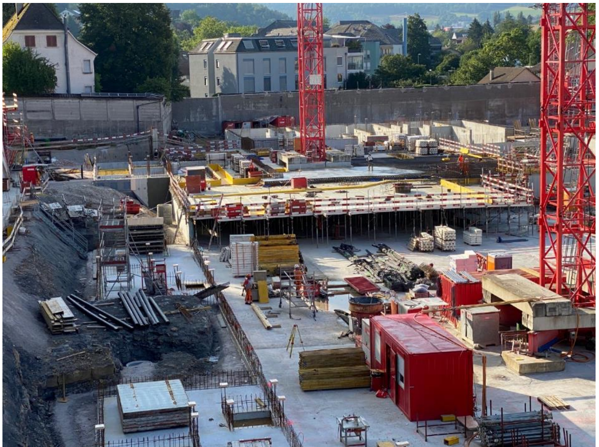
31. Juli 2024: Ein neues Geschoss entsteht
