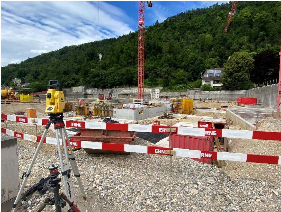
12.06.2024: Es wird fleissig betoniert
