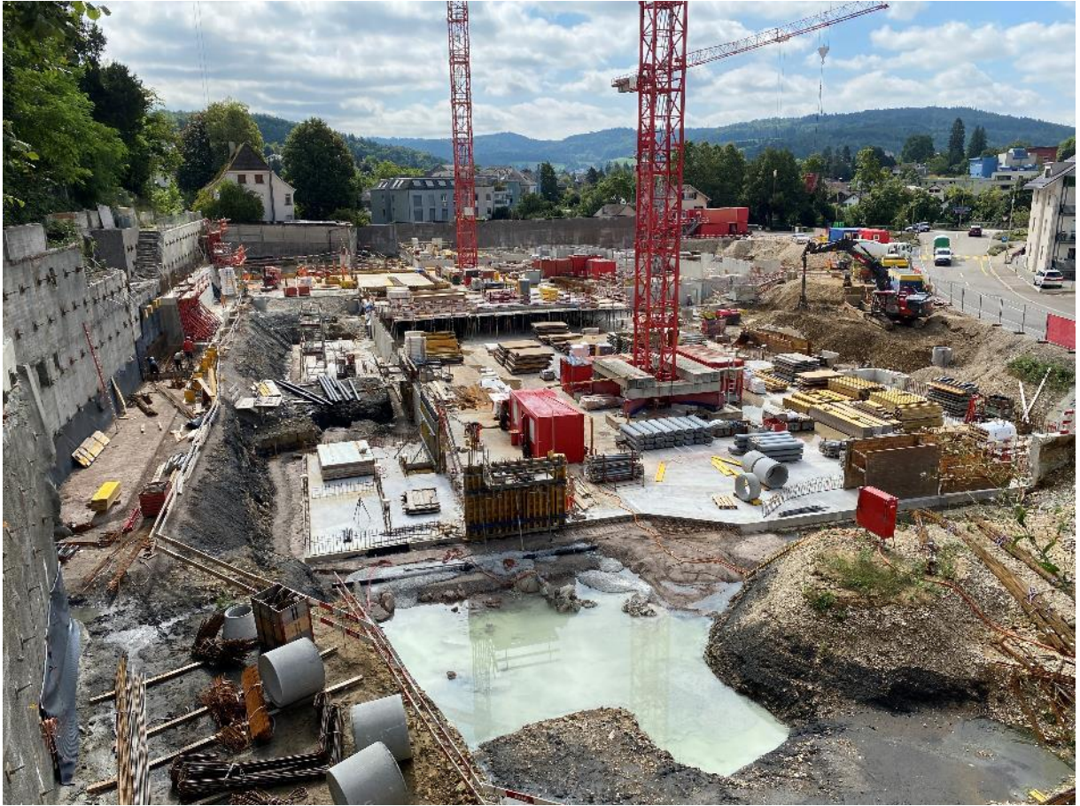
20. August 2024: Hangabsicherung. Erste Decken werden betoniert
