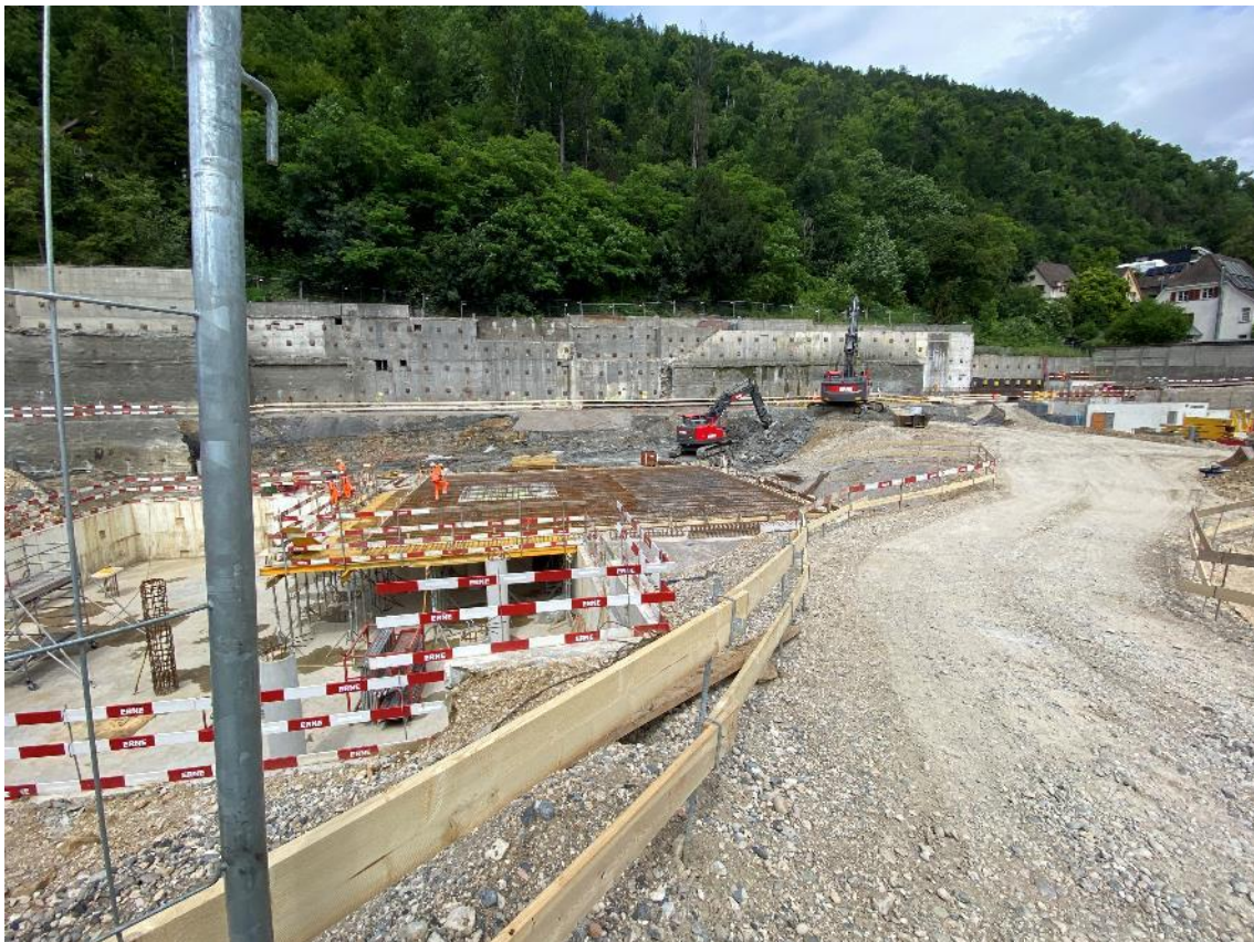
12.06.2024: Es wird fleissig betoniert und weiter gegraben
