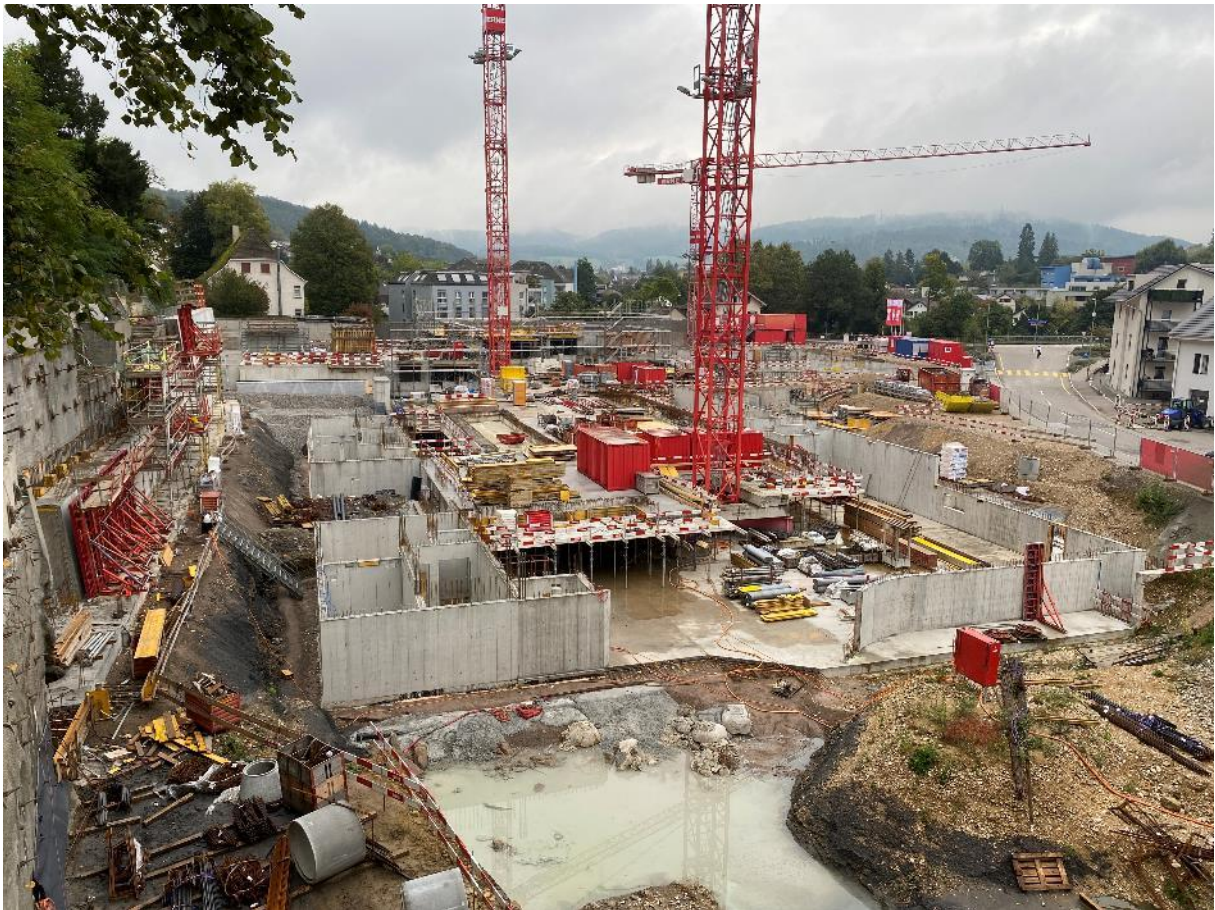
5. Oktober 2024: auch die Stützmauer bergseits kommt voran
