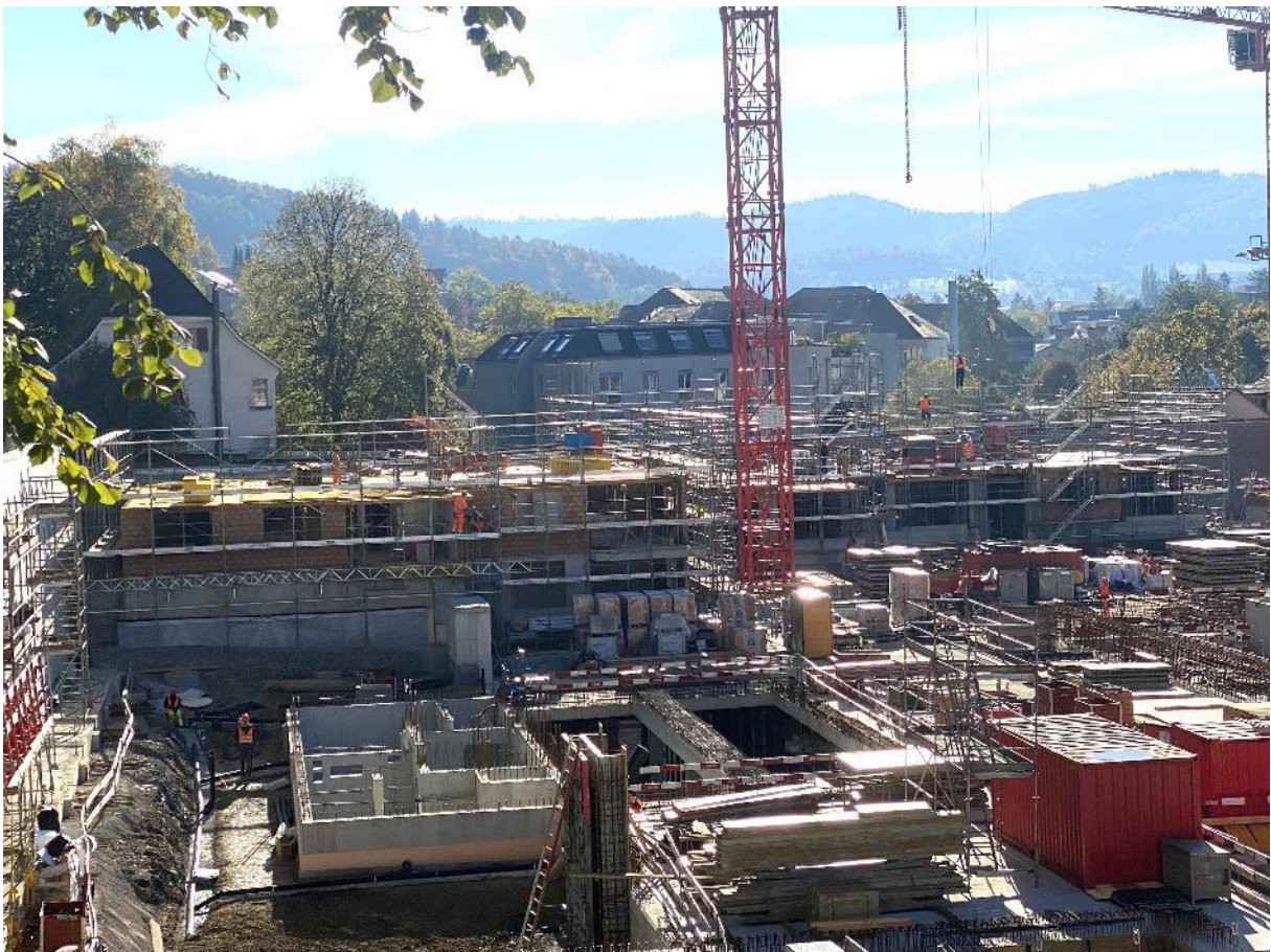
21. Oktober 2024: Nun beginnt der Hochbau
