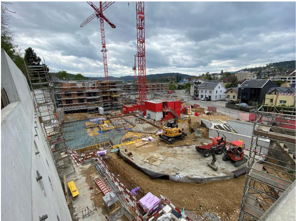
12. April 2025: Stützmauer ist fertig, zwei neue Gebäude beginnen zu wachsen
