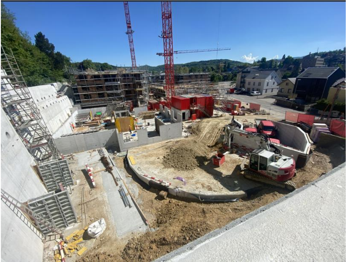
1. Mai 2025: Auch am letzten Gebäude wird nun gearbeitet
