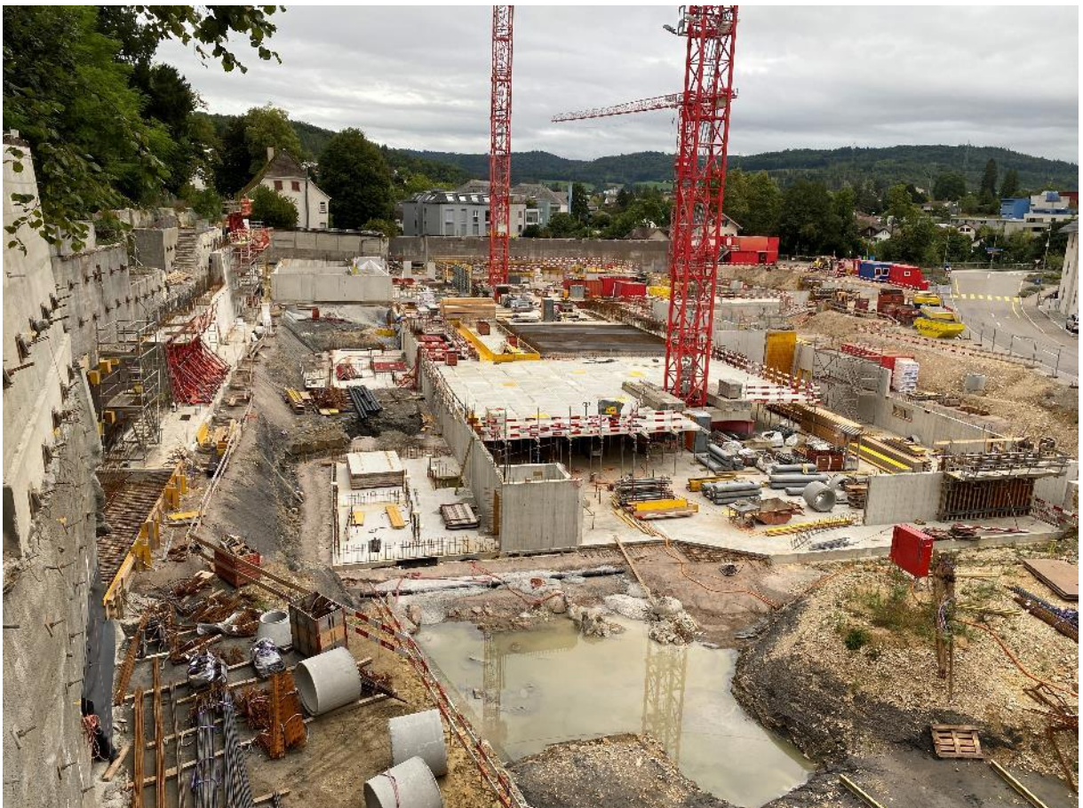
8. September 2024: Nach den Eisenlegern folgt der Beton
