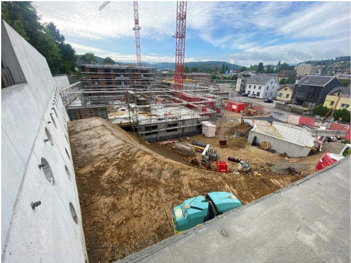
31.05.2025: der letzte Block beginnt in die Höhe zu wachsen, erste Umgebungsarbeiten
