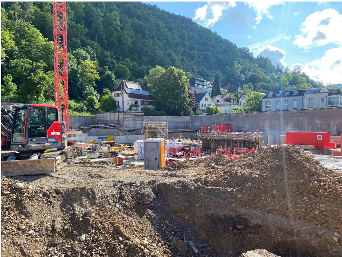
24. Mai 2024: Das Kellergeschoss ist am Entstehen
