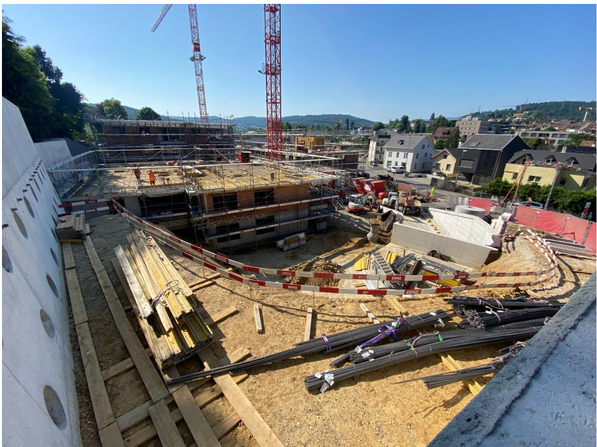
19.06.2025: der letzte Block wächst in die Höhe, Decke vom 1. Stock entsteht
