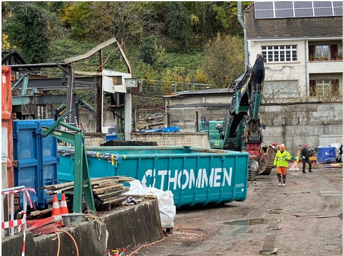
20. November 2023: Die Metallkonstruktionen der Werkhallen werden entsorgt.
