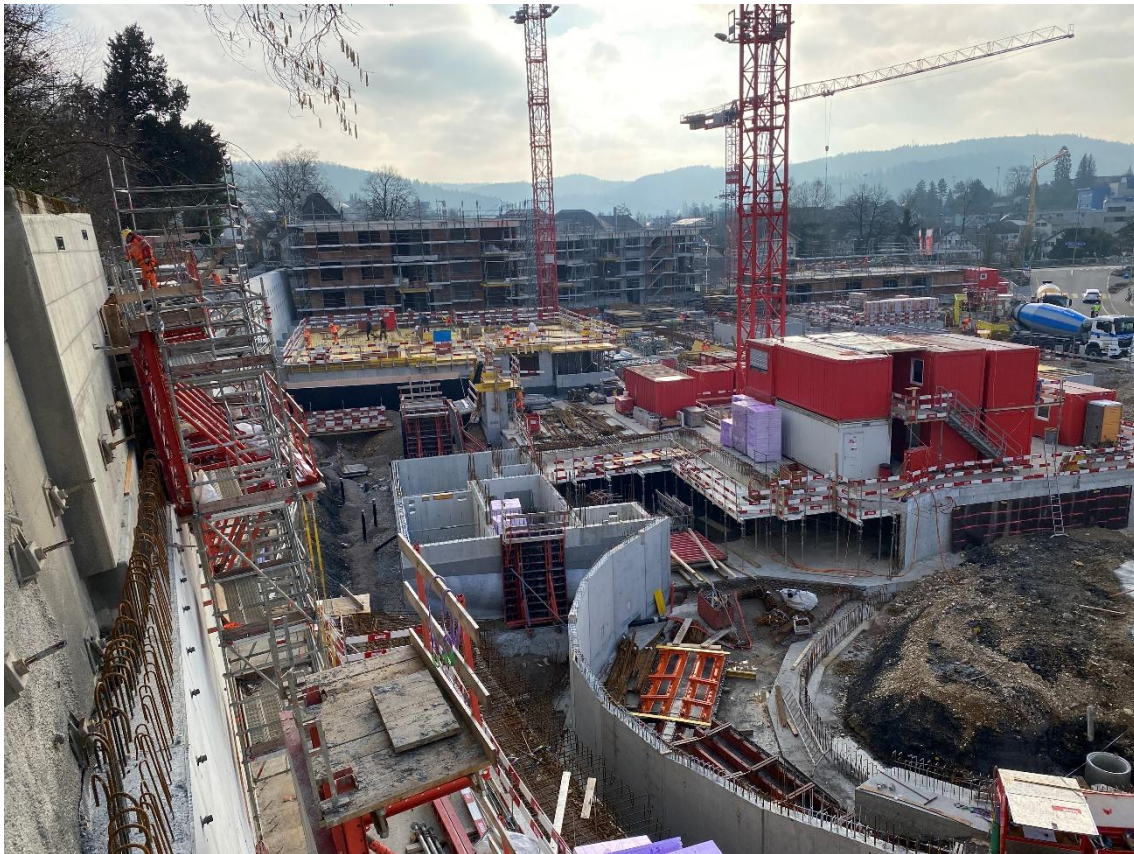
05. Februar 2025: Im Hintergrund wächst der 3. Block in die Höhe.
