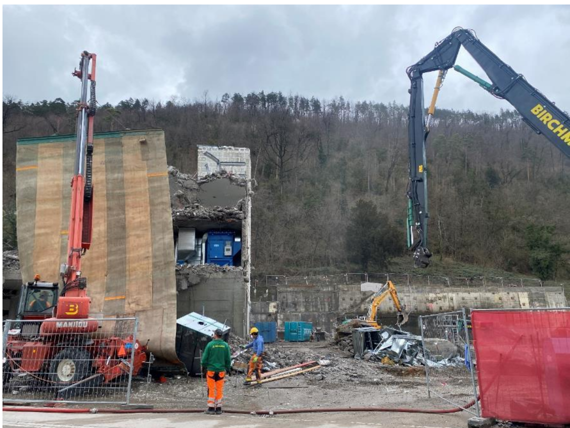
18. März: Mit dem Staubschutz wird Teil um Teil abgeklemmt
