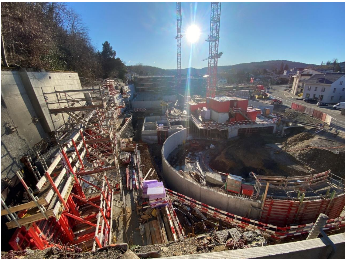
26. Januar 2025: Im Vordergrund entsteht die Einfahrt zur Tiefgarage, Die Stützmauer bergseits nähert sich der Vollendung, die Baucontainer wurden verlegt.
