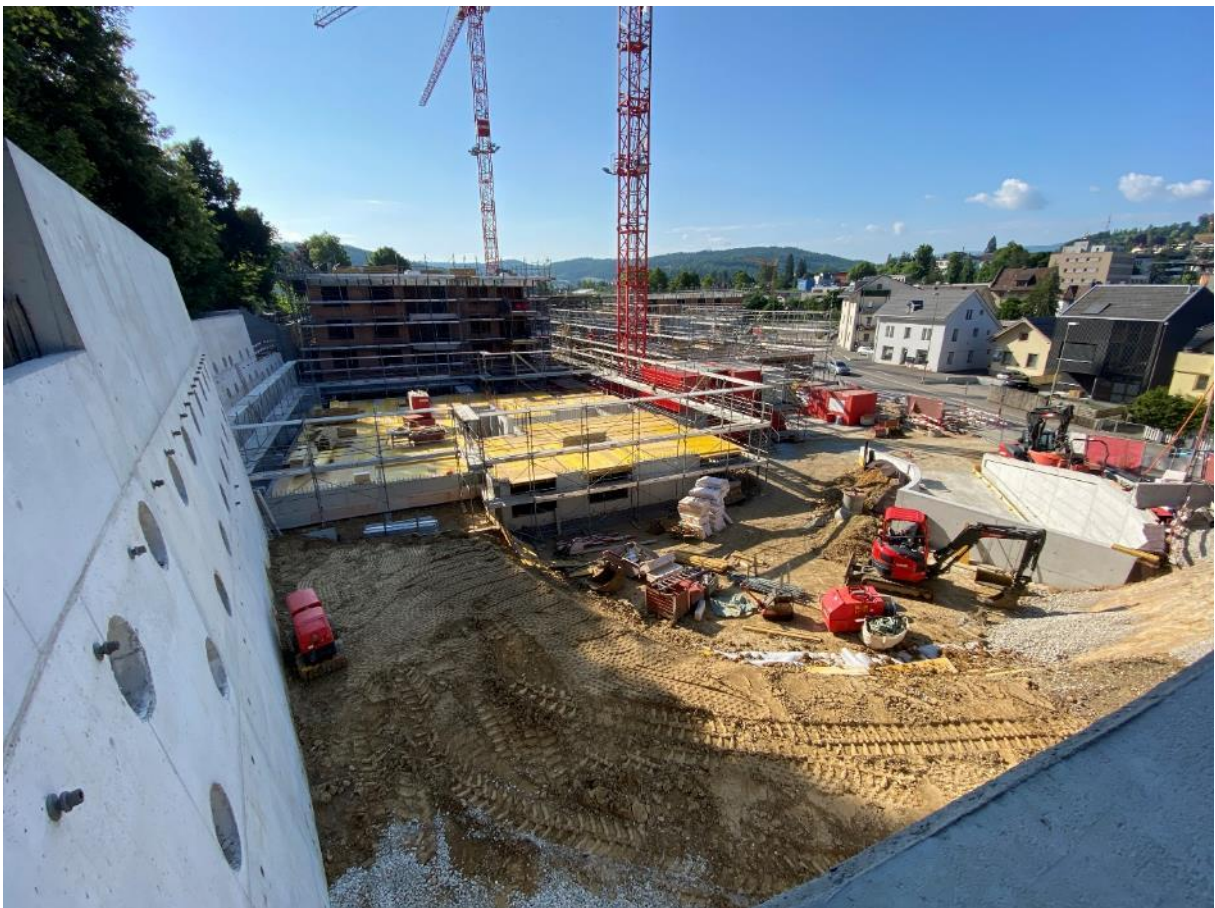
18. Mai 2025: Betondecke folgt
