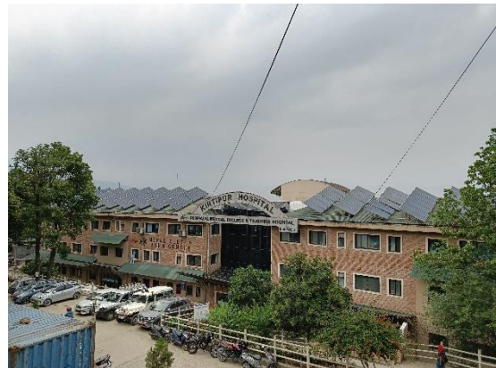
Abbildung 1: Kirtipur Hospital von aussen
