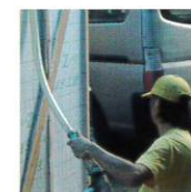
60kgの高压で壁と壁の間に吹き込み
