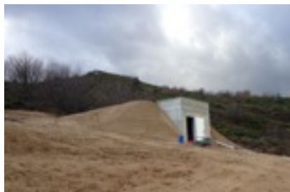
Le nouveau réservoir du-village
