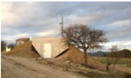
La station de pompage de Tallans
