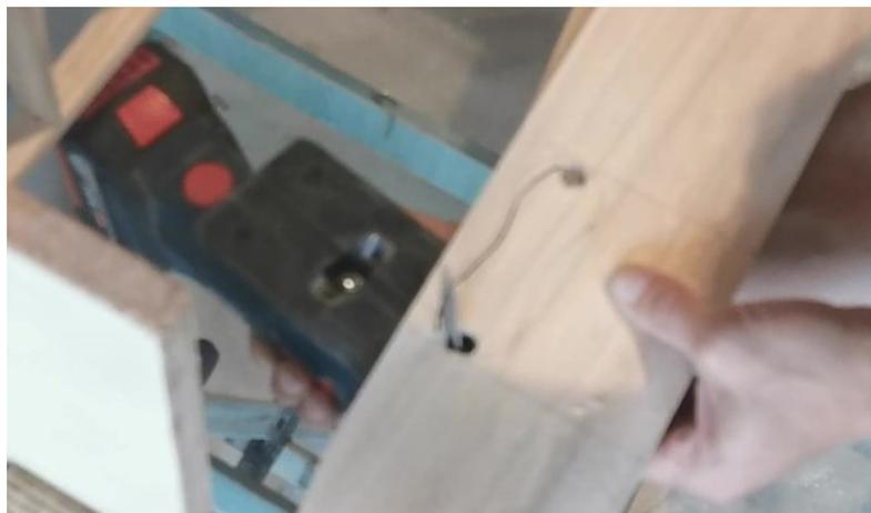
Jetzt das Beplankungsteil an ser Geplanten Stelle positionieren und mit der Finbox auf passung kontrollieren, gegebenenfalls mit Raspel und Schleifpapier nacharbeiten bis man die Finbox problemlos einsetzen kann.
