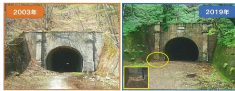
写真-20 二ツ小屋隧道東坑口
