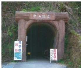
写真-24 中山手掘り隧道
