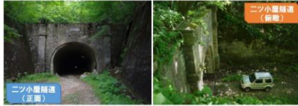
写真-28 ニツ小屋隧道
