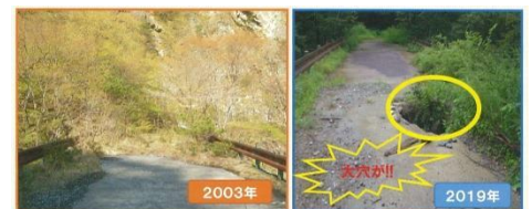
写真-18 新沢橋(橋上)
