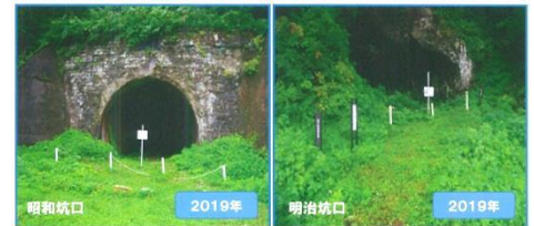
写真-17-2 栗子隧道昭和坑口・明治坑口
