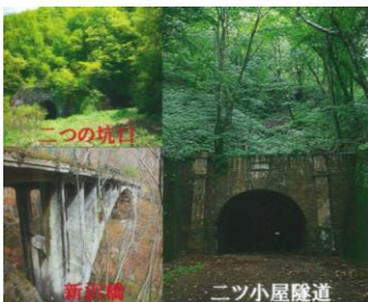
写真-11 隧道・橋
