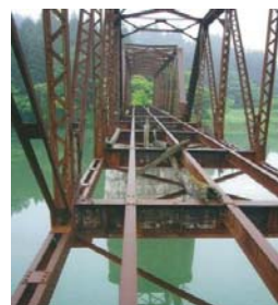
写真-2 西会津町 旧柴崎橋
