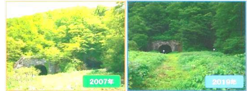
写真-17-1 栗子隧道(米沢側)坑口前広場
