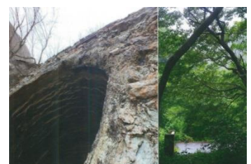
写真-9 栗子隧道坑口・杭甲橋
