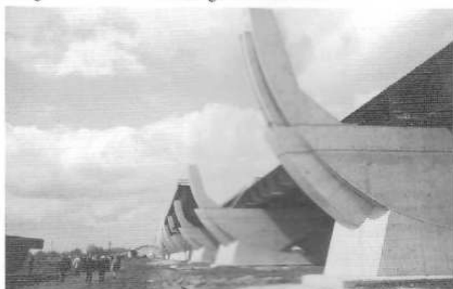
Wasserkreuz Magdeburg Stützen für Trogbauwerk über Land
