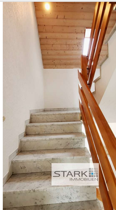
OG Treppe ins DG
